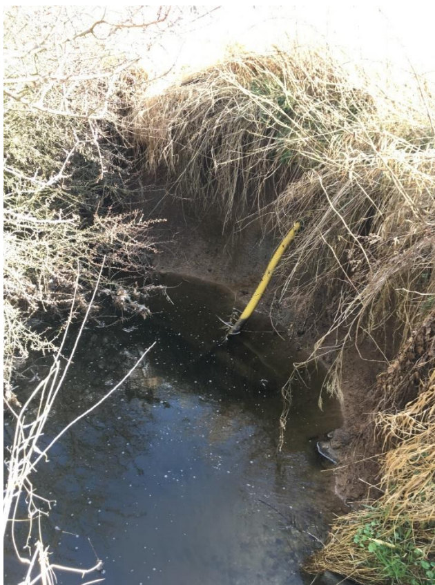
Obrázek 3.24: Vyústění trubkové drenáže v boku koryta (zdroj: vlastní)
