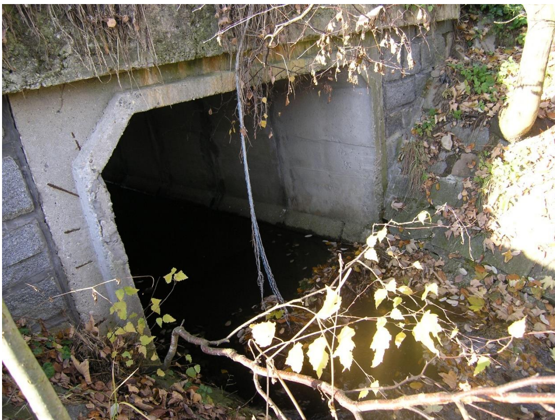
Propustek – křížení vodního toku a polní cesty, druhý úsek (zdroj: vlastní)
