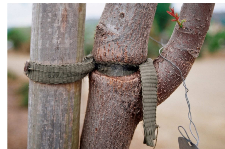
Obr. č. 9 - Zanedbání kontroly úvazku
