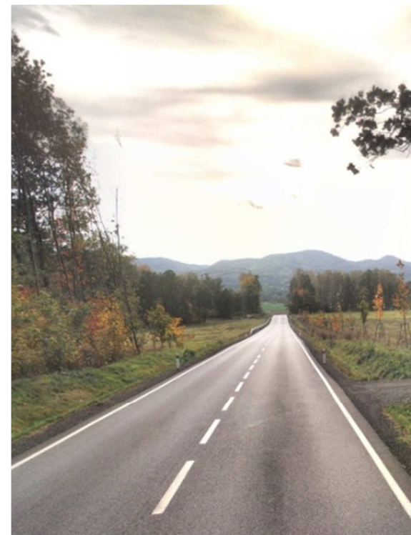
Obr. č. 3 - Kočárová alej Raspenava, nový stav (Google maps, 2016)
