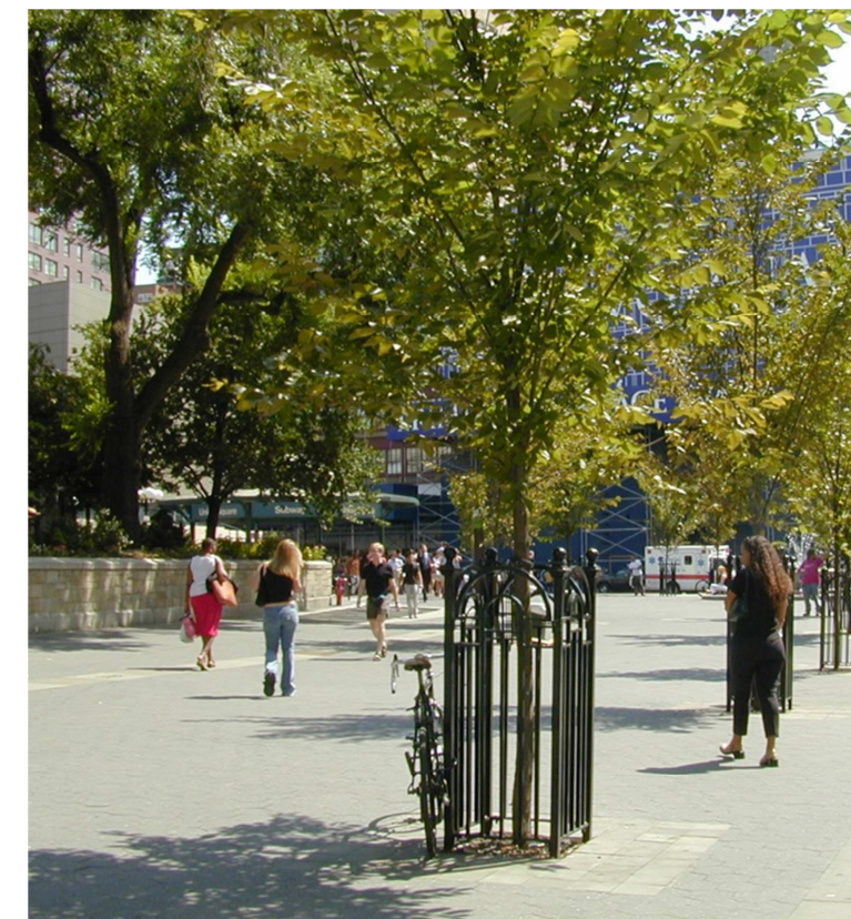
Obr. č. 8 - Podpůrná konstrukce výsadby
