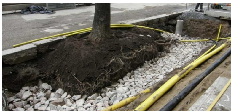
Obr. č. 5 - Odhalené kořeny, doplnění strukturovaného substrátu, Stockholm (Bjorn, 2015)
