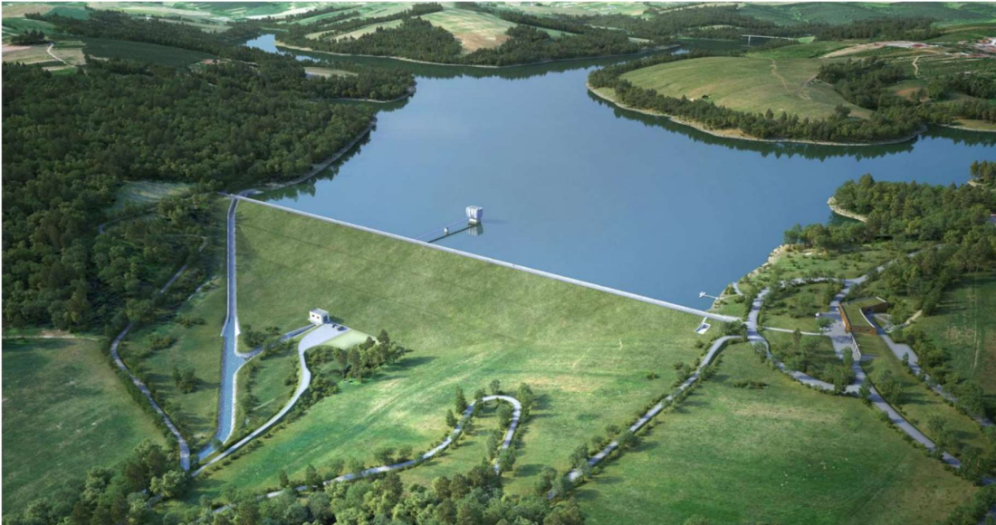
Obrázok 8.1: Vizualizácia priestoru sypanej zemnej hrádze vodného diela Vlachovice [16]
