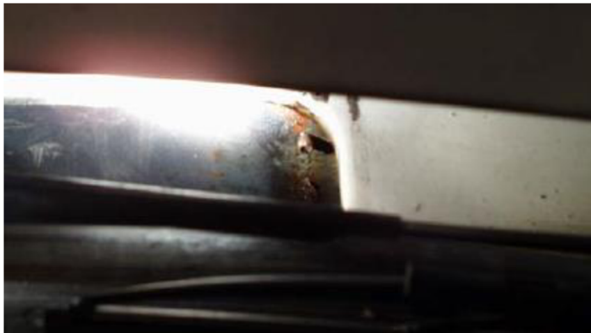
Obrázek 22 - Rubová strana výrobního čísla vozidla NISSAN. Ve střední části je viditelný svislý svar, který je napaden povrchovou korozí (světle hnědý odstín). Svar vede v těsné blízkosti nýtového spoje (číslo VIN bylo vevařeno do příčky vozidla) 47
