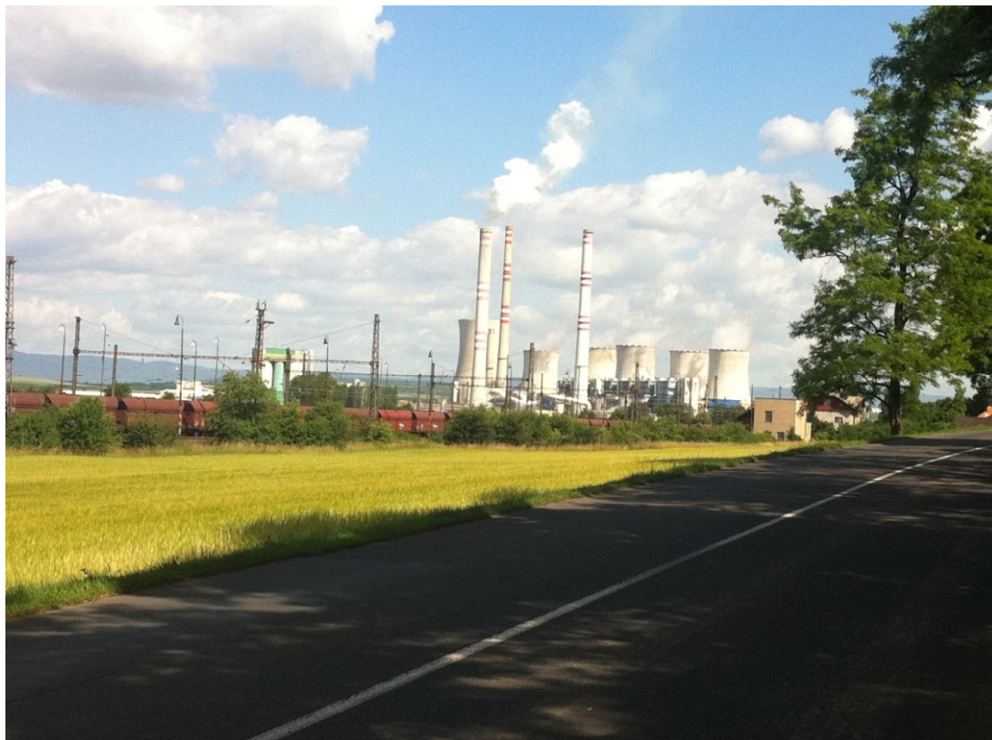
Obr. č. 5: Elektrárna Počerady (zdroj: autor)
