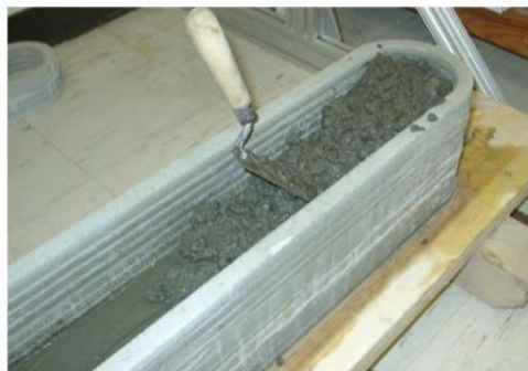
Obr 3- 3 Tisková hlava metody CC (vlevo), plnění stěny betonem (vpravo). [12][13]
