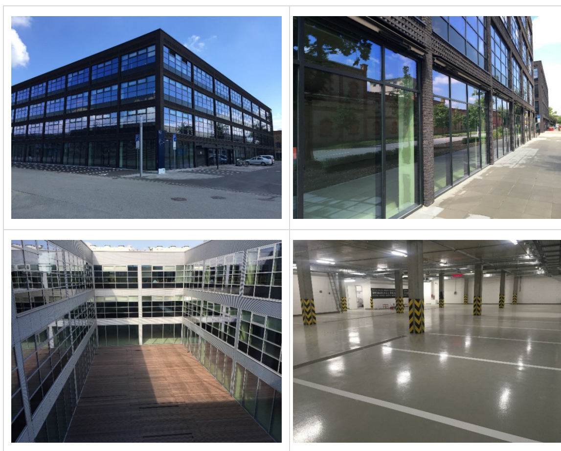
Obrázok č. 21 – Konštrukcie budovy
