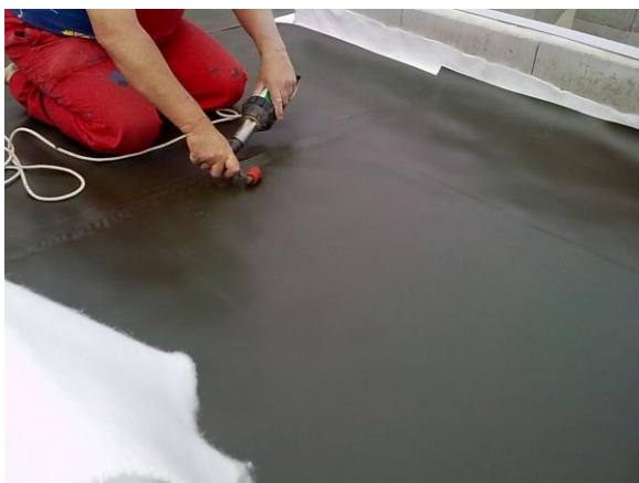
Obr. č. 8 Svařování izolační fólie
