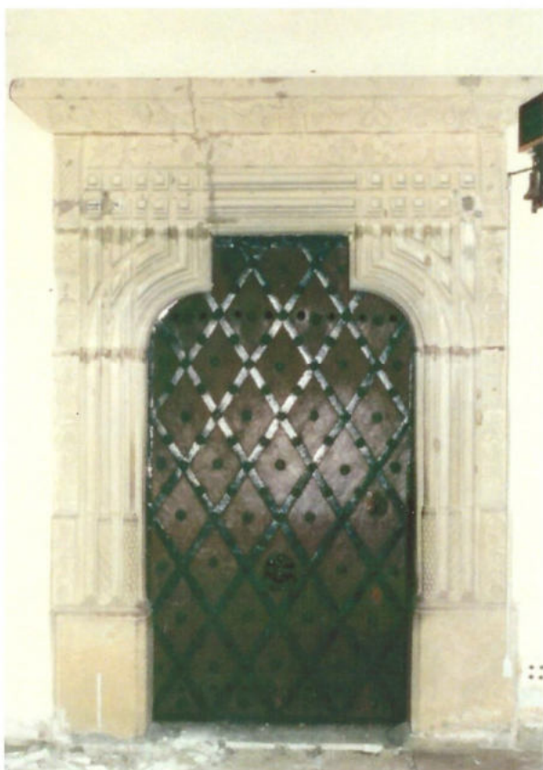
Obr. 117. Presbytář. Stávající goticko- renesanční portál s letopočtem 1532.
