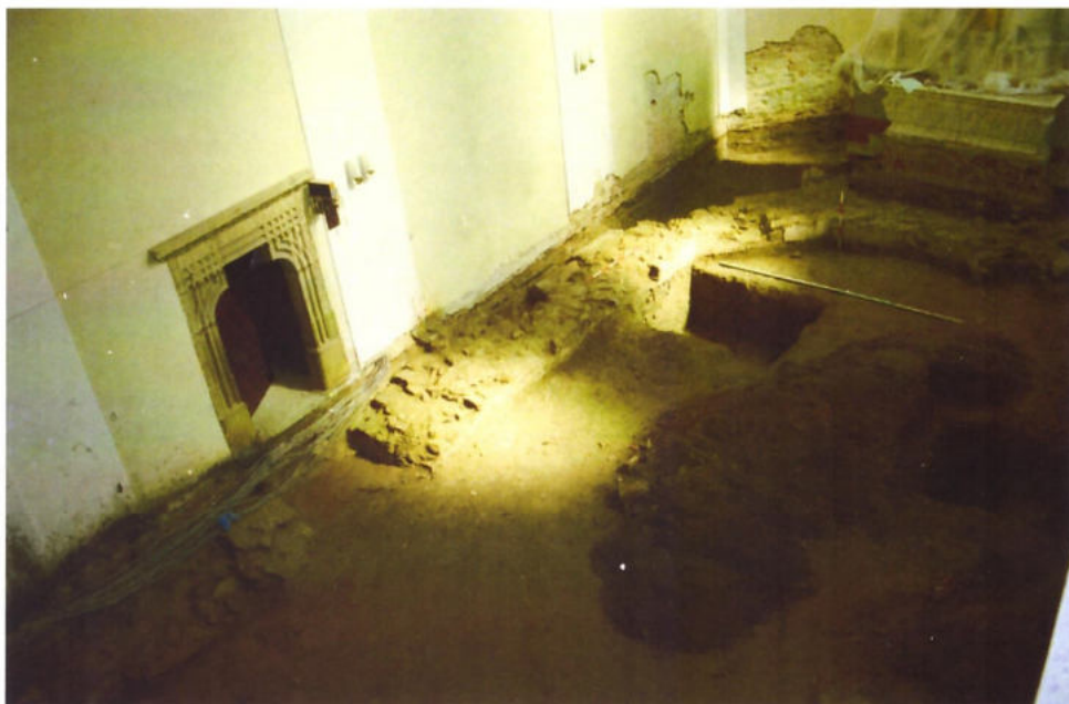
Obr. 115. Presbytář. Celkový pohled od Z na zed' 12/99. Foto P. Večeřa. Č. neg. 105655.
