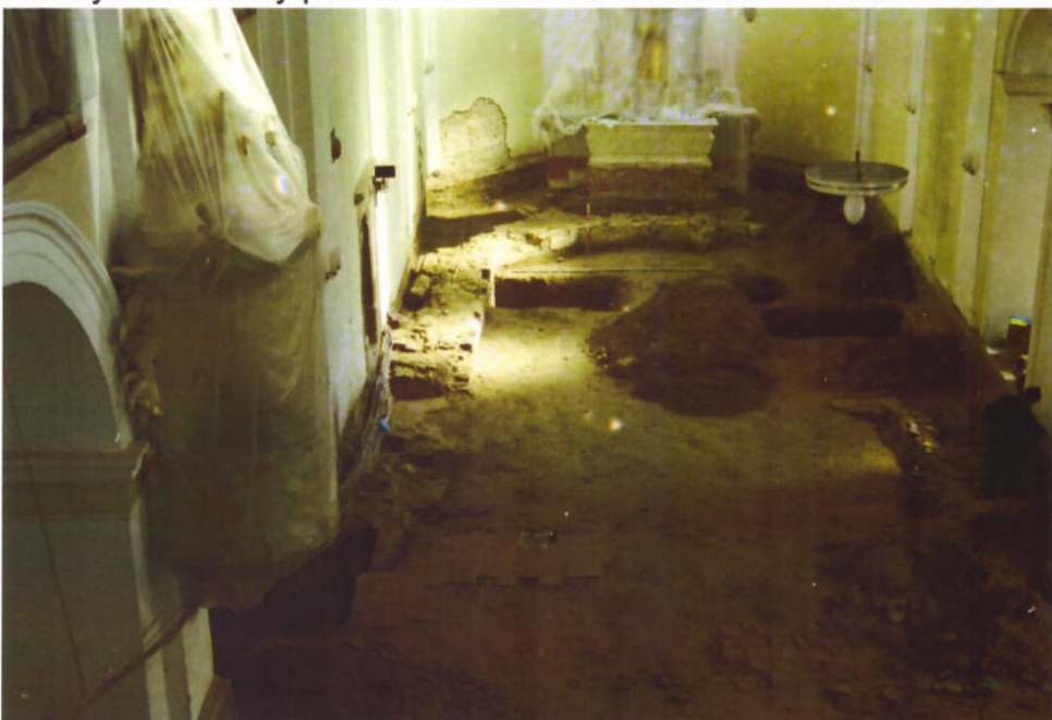
Obr. 116. Presbytář. Celkový pohled od SZ na zed' 12/99. Foto P. Večeřa. Č. neg. 105657.
