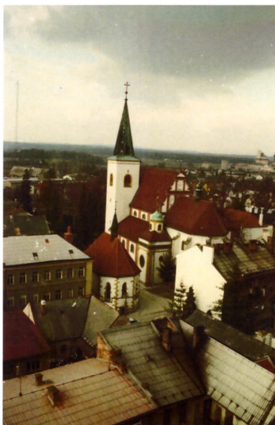
Obr. 72. Farní kostel sv. Marka od JV. Foto K. Faltýnek. Č. neg. 106229.
