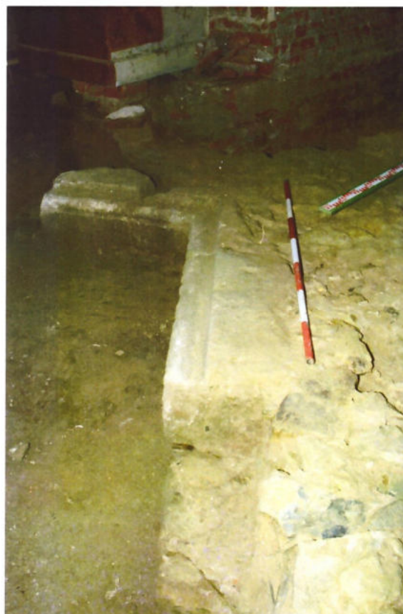
Obr. 110. V část zdi 12/99 se soklovou římsou od S. Foto Večeřa. Č. neg. 105647.
