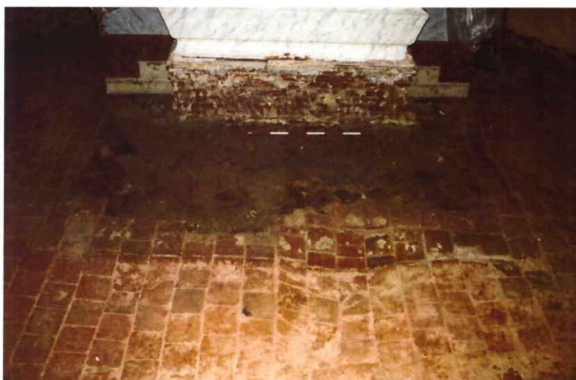
Obr. 89. Dlažba 1/99 a 2/99, otisk schůdků 3/99 od SZ. Foto K. Faltýnek. Č. neg. 82880.
