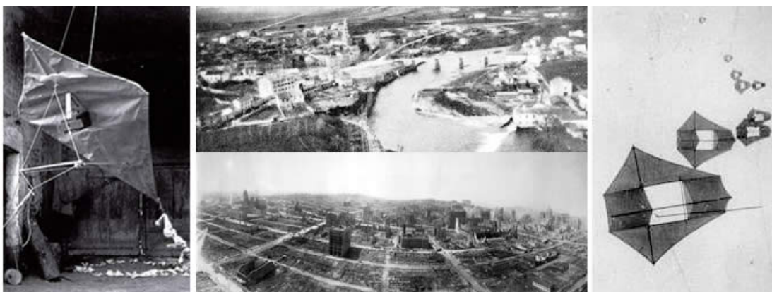
Obrázek 1 - drak používaný pro letecké snímkování, včetně ukázky snímku [14]
