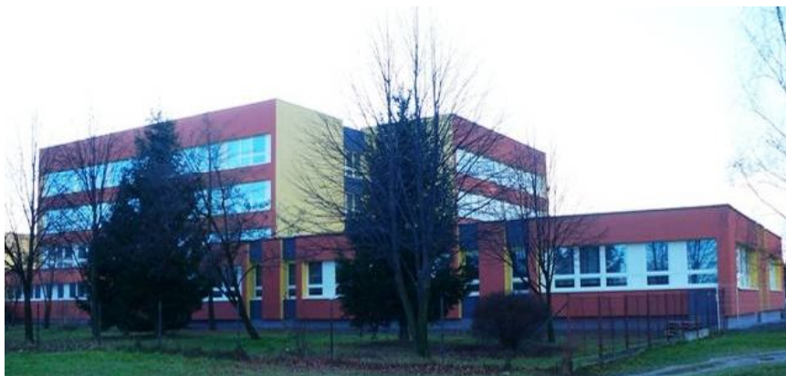
Obr. 38: Střední průmyslová škola stavební Ostrava
