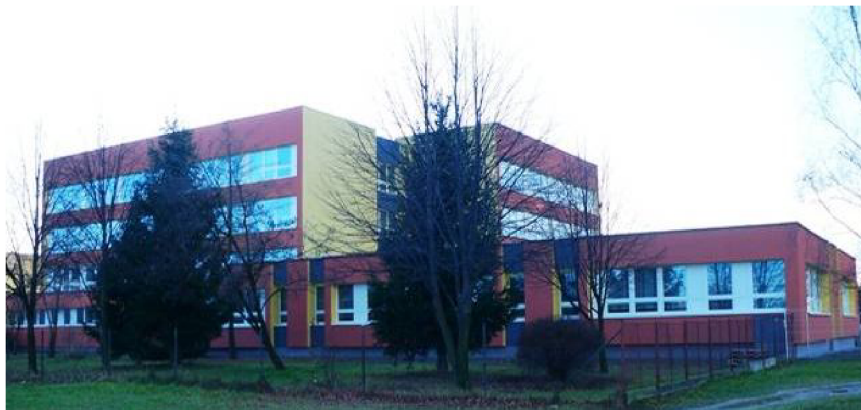
Obr. 38: Střední průmyslová škola stavební Ostrava
