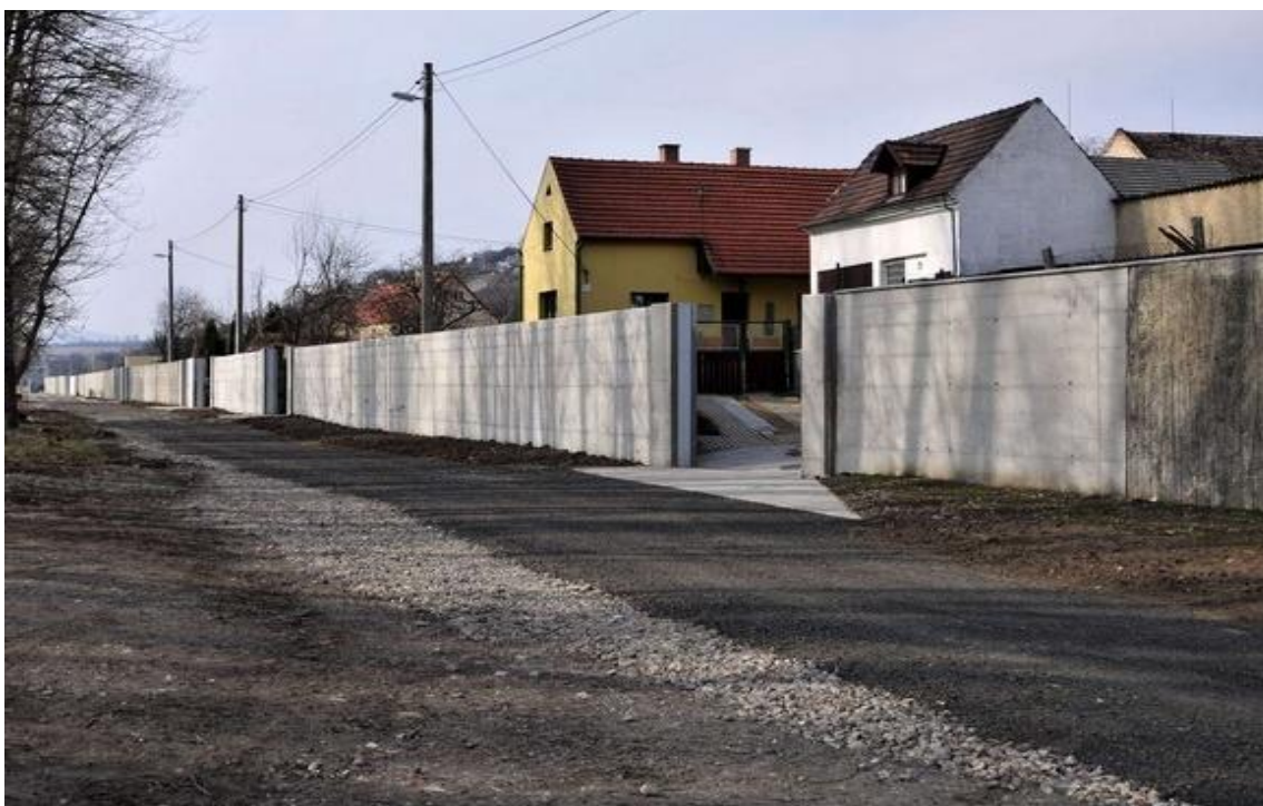
Protipovodňová zeď v Křešicích v ulici na břehu Labe (Eagri)
