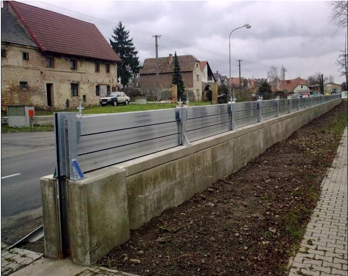
Protipovodňová opatření v Pražské ulici u silnice II/261 (Eagri)
