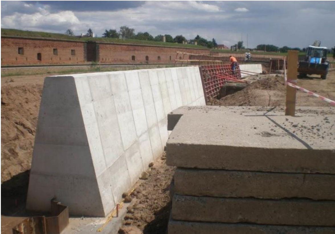
Výstavba zdi chránící východní část Tereziína - Malou pevnost (Eagri)
