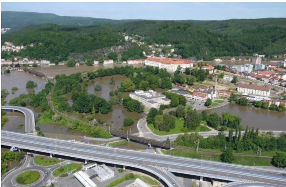
Protipovodňová opatření v Děčíně na pravém břehu Labe u soutoku s Ploučnicí (Eagri)
