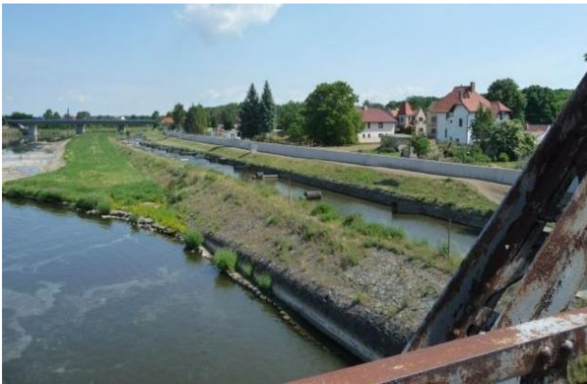
Protipovodňová zeď v lokalitě „Na dílcích“ (Eagri)
