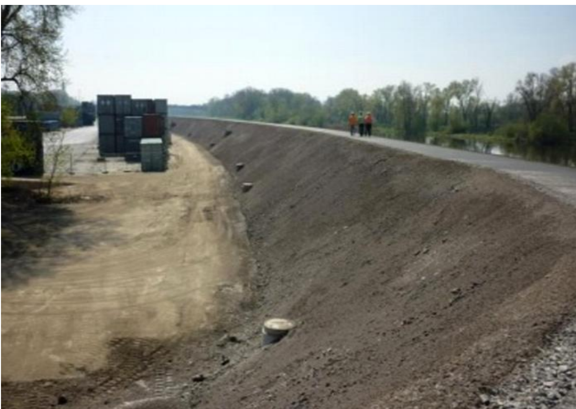
Zemní hráz v severní části přístavu (Eagri)
