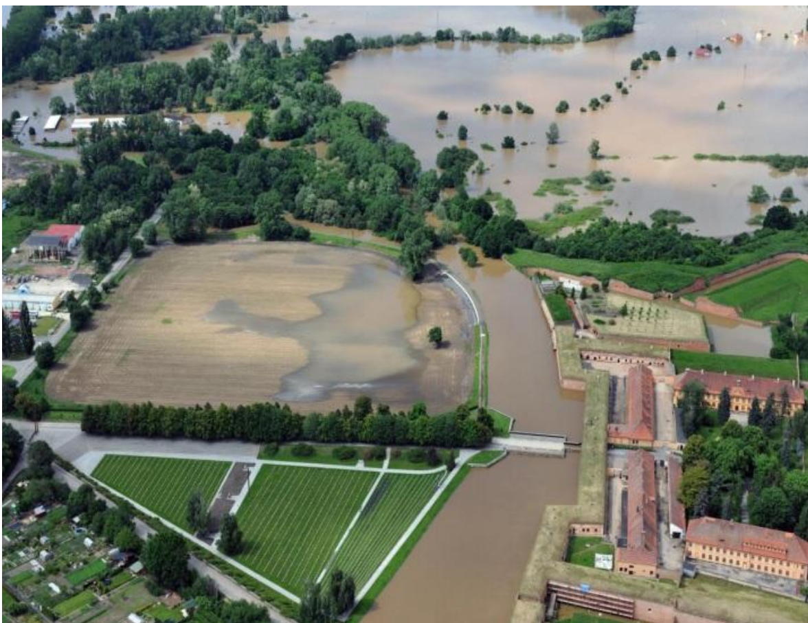
Protipovodňová opatření chránící Malou pevnost při povodních v červnu 2013 (Eagri)
