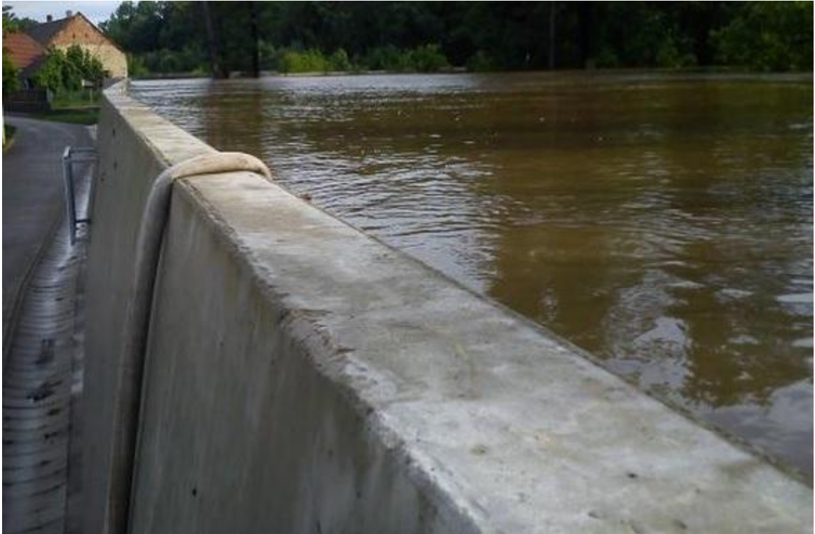
Protipovodňová hráz v Hoříně u Mělníka (Zdeňka Vaculíková, zdroj facebook)
