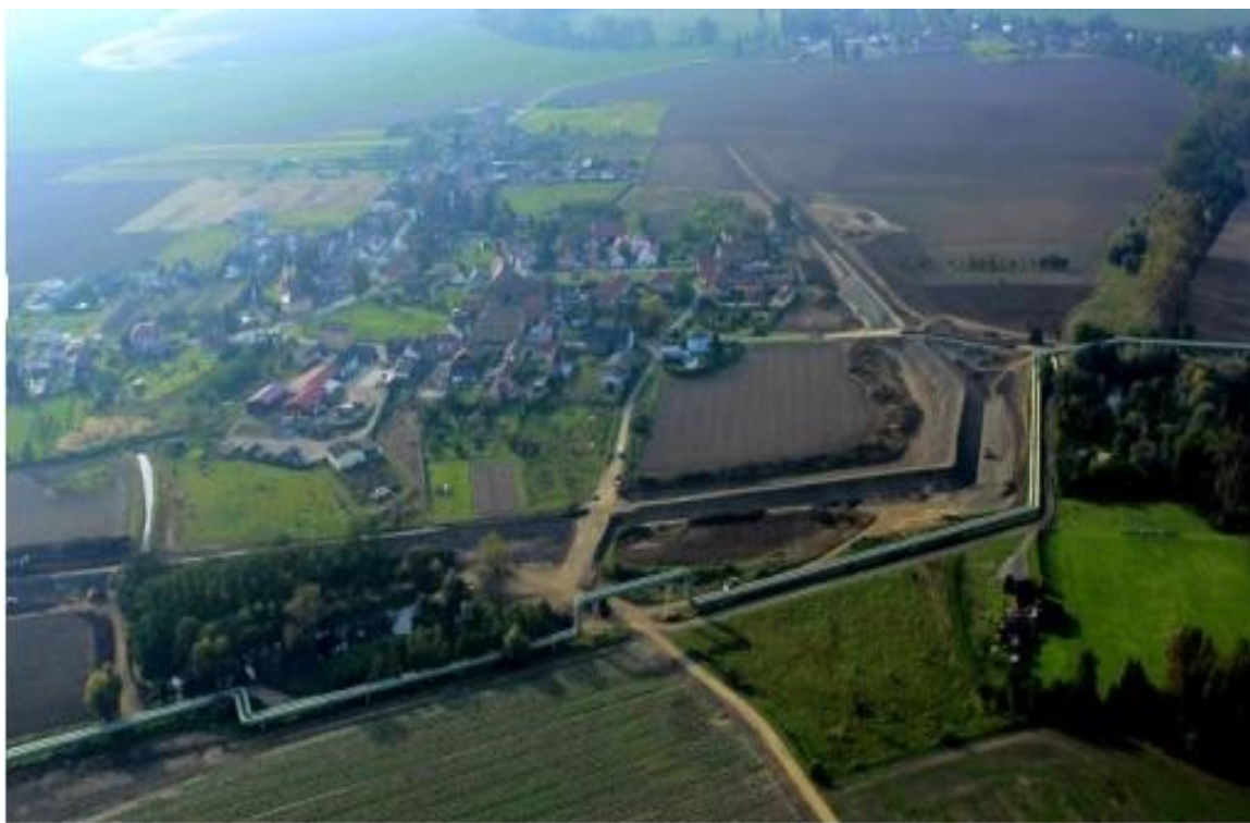
Protipovodňová hráz na jaře 2013 v průběhu výstavby (Eagri)
