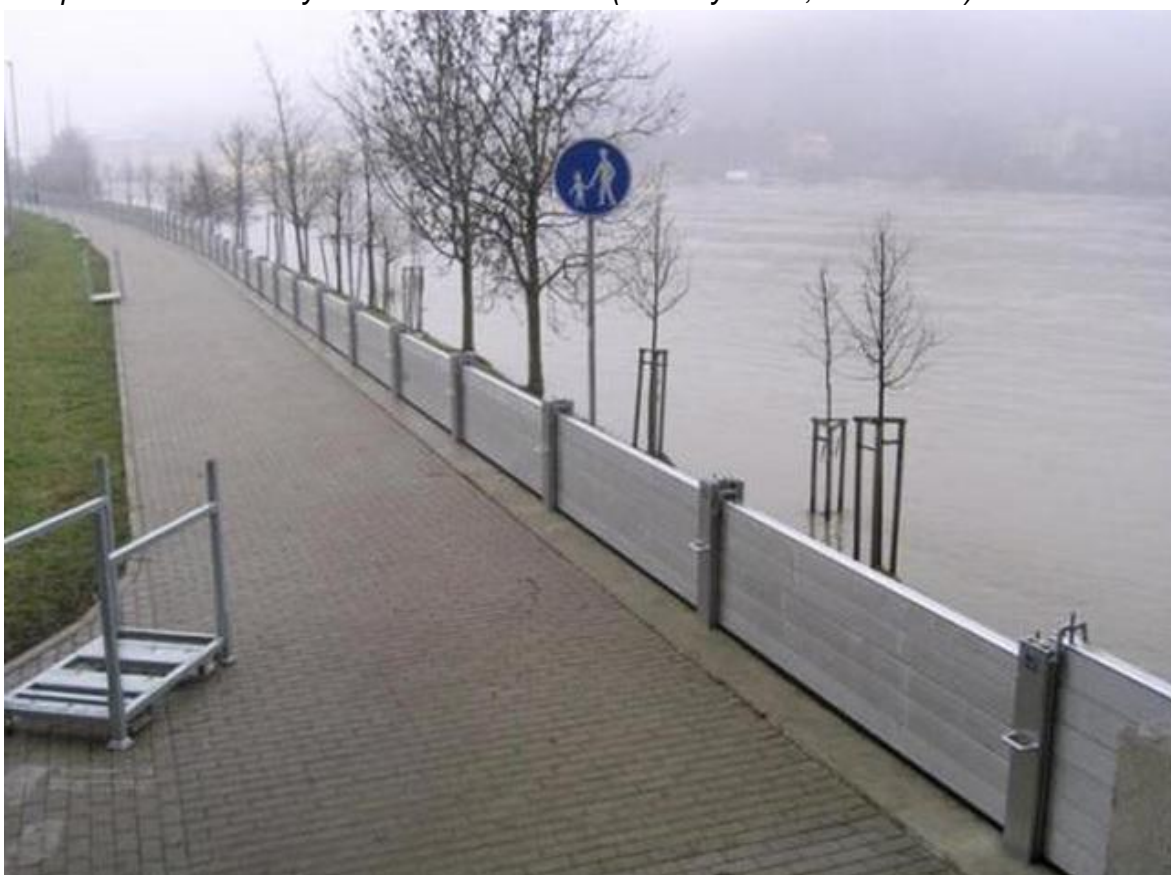
Protipovodňové zábrany chránící čtvrť Střekov (kr-ustecky.cz)
