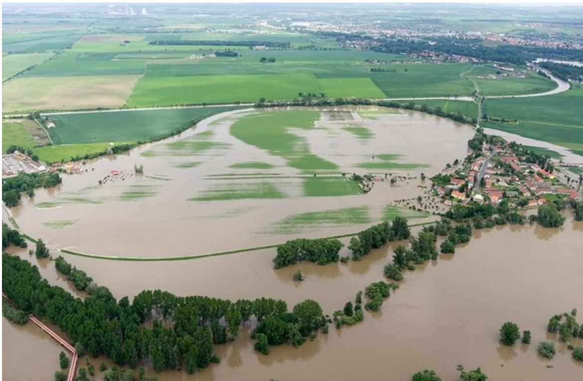
Zatopený Zelčín a Vrbno (vpravo). Nasnímku je vidět protipovodňová hráz a její protržení.
