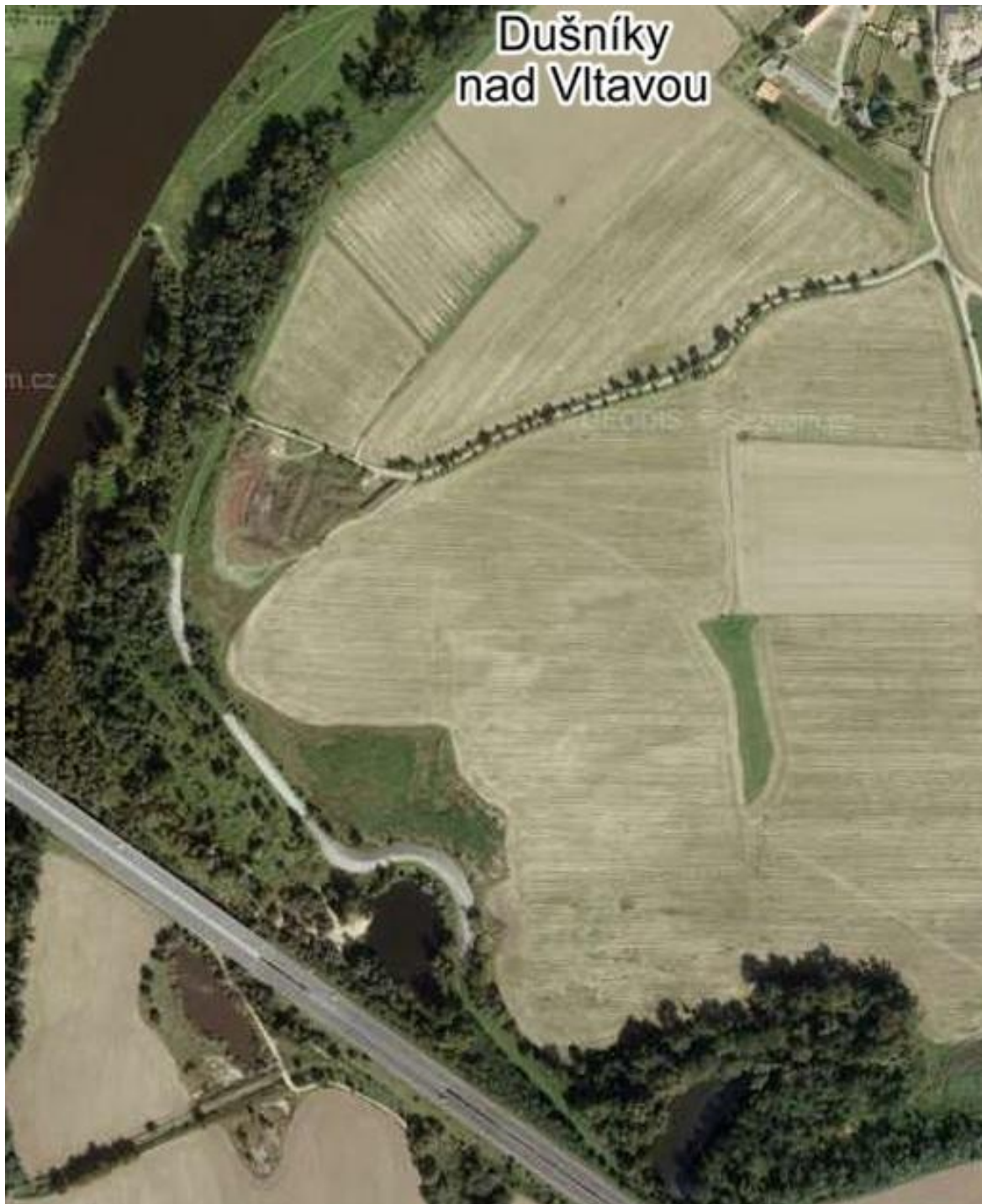
Protipovodňový val chrání obec Dušníky nad Vltavou na leteckém snímku. Jižní část je zděná, část kolem řeky tvoří zemní hráz (Mapy.cz)
