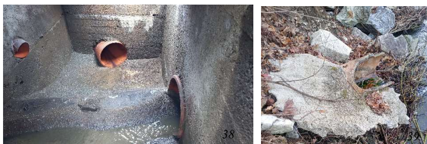
Obrázek 38, 39: Odlehčovací komora OK 18, přepadová hrana (foto, 2023); Vyústění z OK 18, (foto, 2023)
