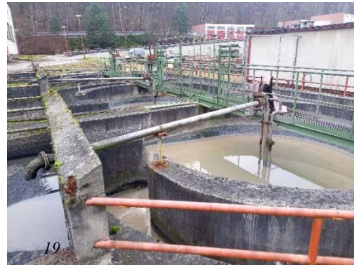
Obrázek 18, 19: vířivý separátor, (Čebín, 2022) , vířivý separátor na ČOV Český Krumlov, (Český Krumlov, 2022)
