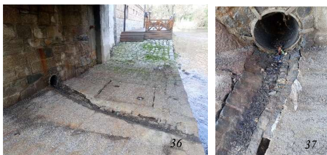
Obrázek 36, 37: Odlehčovací komora OK25, přepadová hrana (foto, 2021); Vyústění z OK25, (foto, 2021)
