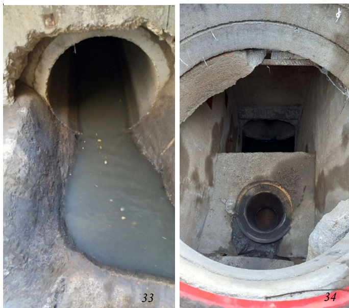
Obrázek 33, 34: Odlehčovací komora OK2 , přepadová hrana (foto, 2023); Vyústění z OK2, (foto, 2023)
