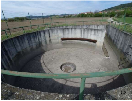
Obrázek 18, 19: vířivý separátor, (Čebín, 2022) , vířivý separátor na ČOV Český Krumlov, (Český Krumlov, 2022)
