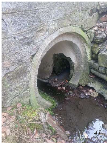
Obrázek 40, 41: ústí do zatrubněného vodoteče (foto, 2023); ústí kanalizační přípojky, (foto, 2023)
