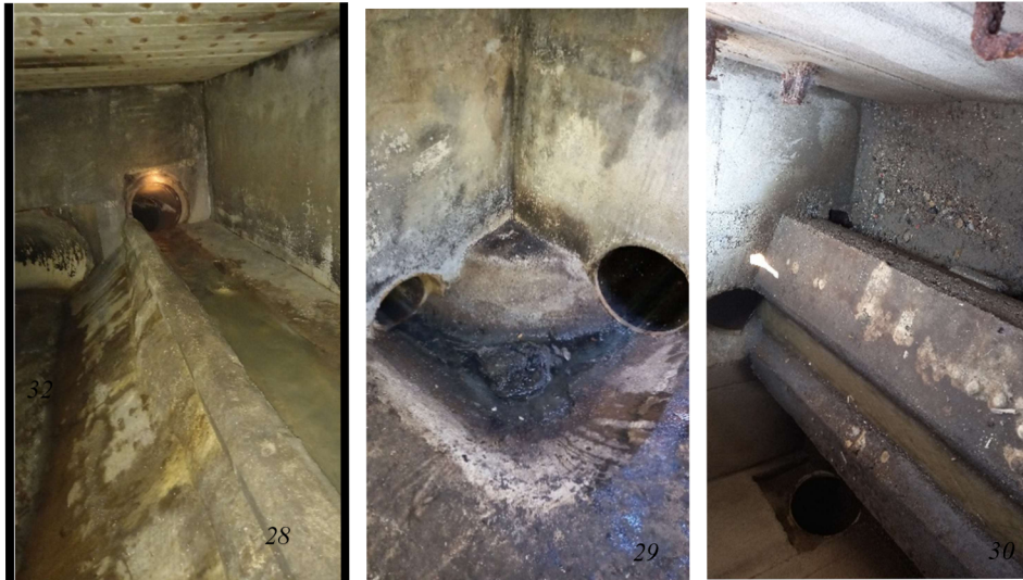
Obrázek 28, 29, 30 : OK s přepadem jednostranným bočním se šikmou hranou (foto 2023); OK s přepadem přímým s kolmou hranou (foto, 2023); OK s přepadem oboustranným s rovnou hranou
