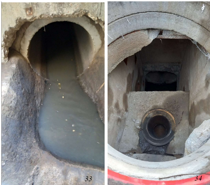
Obrázek 33, 34: Odlehčovací komora OK2 , přepadová hrana (foto, 2023); Vyústění z OK2, (foto, 2023)
