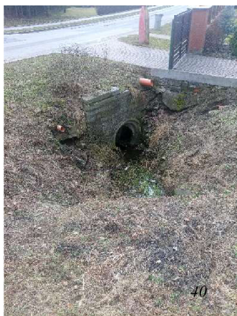
Obrázek 40, 41: ústí do zatrubněného vodoteče (foto, 2023); ústí kanalizační přípojky, (foto, 2023)
