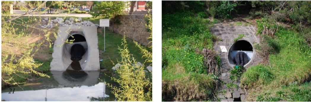
Obrázek 21, 22: příklady záchytných sítí ( Storm Water Systems, Inc. 2023 )
