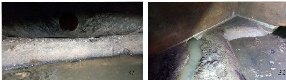
Obrázek 31, 32: OK s přepadem jednostranným bočním s přímou hranou (foto, 2023); OK s přepadem přímým se šikmou hranou (foto, 2023)
