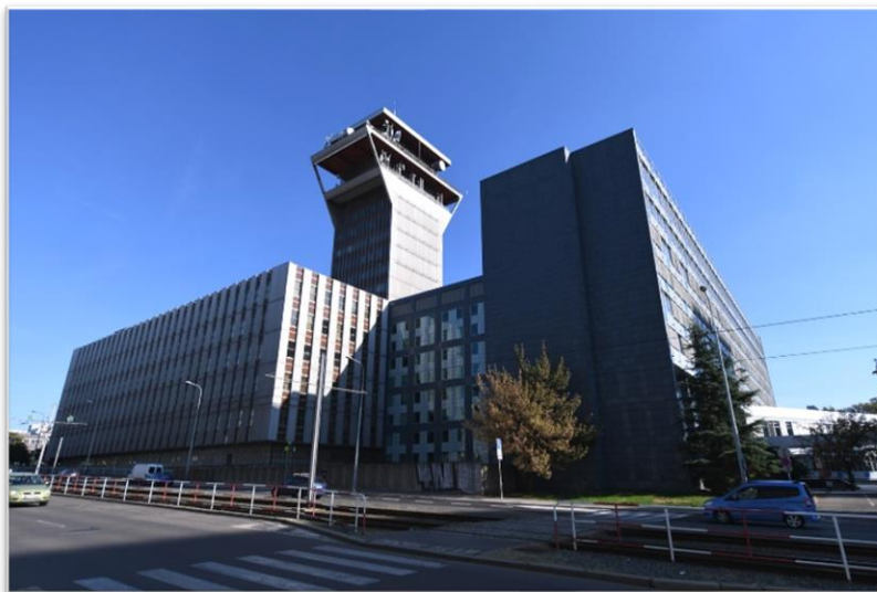
Obrázek 16: Budova bývalého Telecomu na pražském Žižkově (Al Design, 2021)
