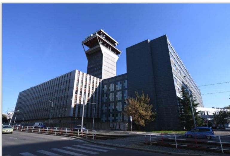
Obrázek 16: Budova bývalého Telecomu na pražském Žižkově (AI Design, 2021)
