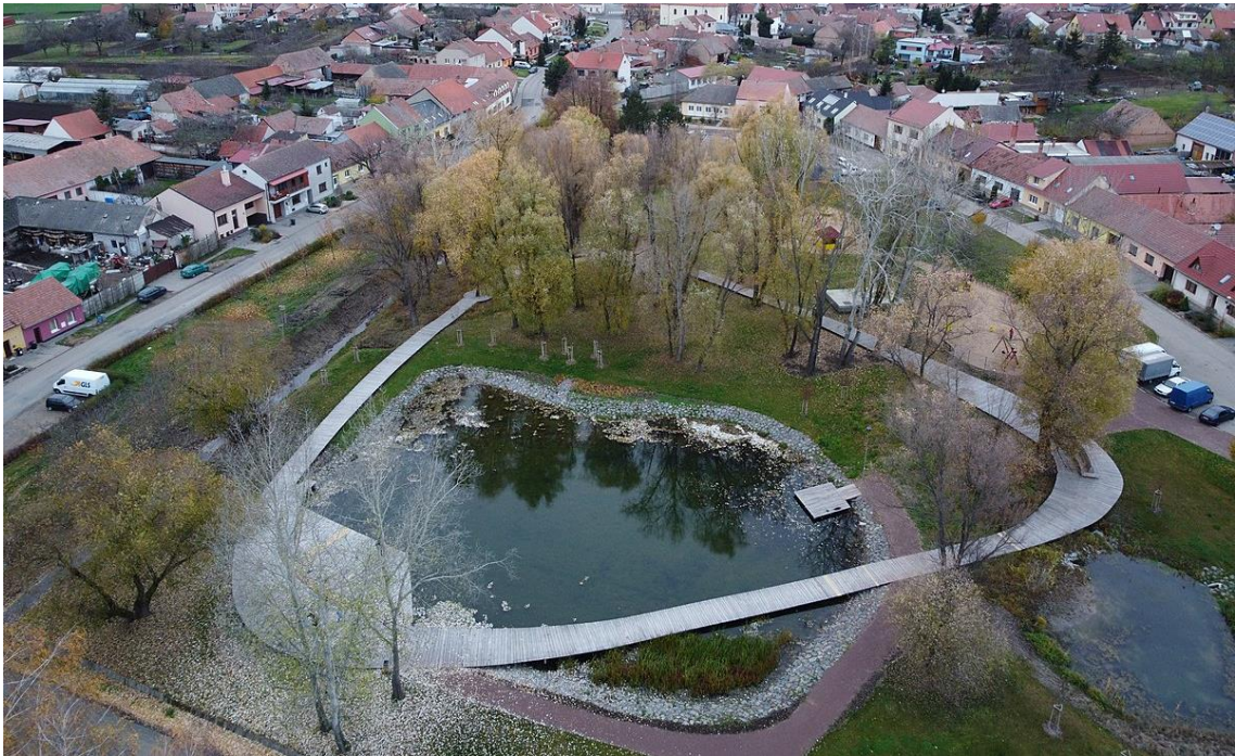
Obr. 16- Retenční nádrž se stálou hladinou, Bratčice, Brno - venkov (Zdroj: [41])
