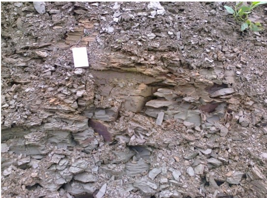
Obr. č. 3. - Charakter rozpukání jílovců (zdroj: vlastní)
