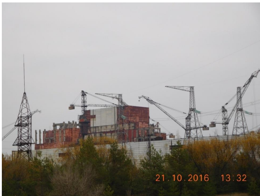
Pohled na nedostavěné bloky 5 a 6
