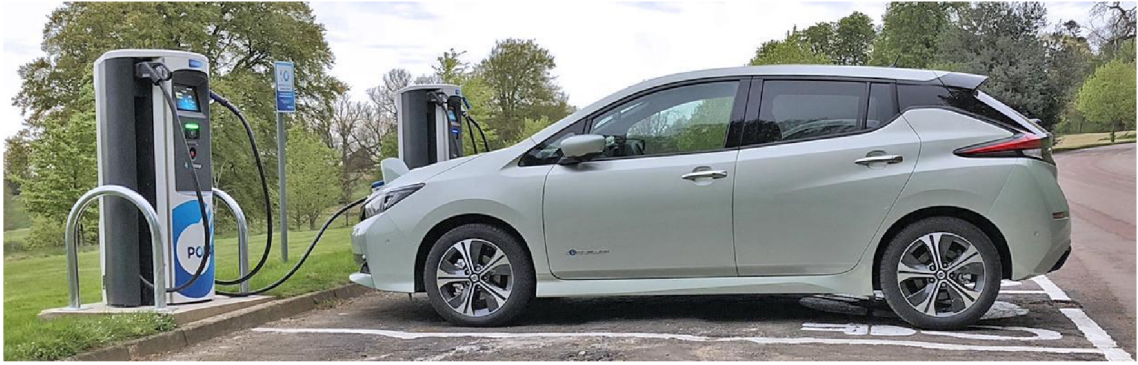
Obr. 2.13 - Veřejná dobíjecí stanice
