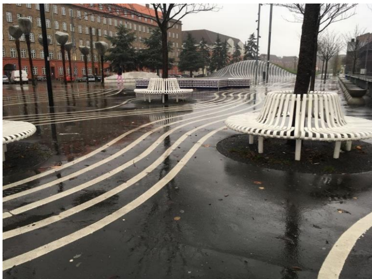
Obr.č.52: Superkilen- betonová část (foto: vlastní 2019)
