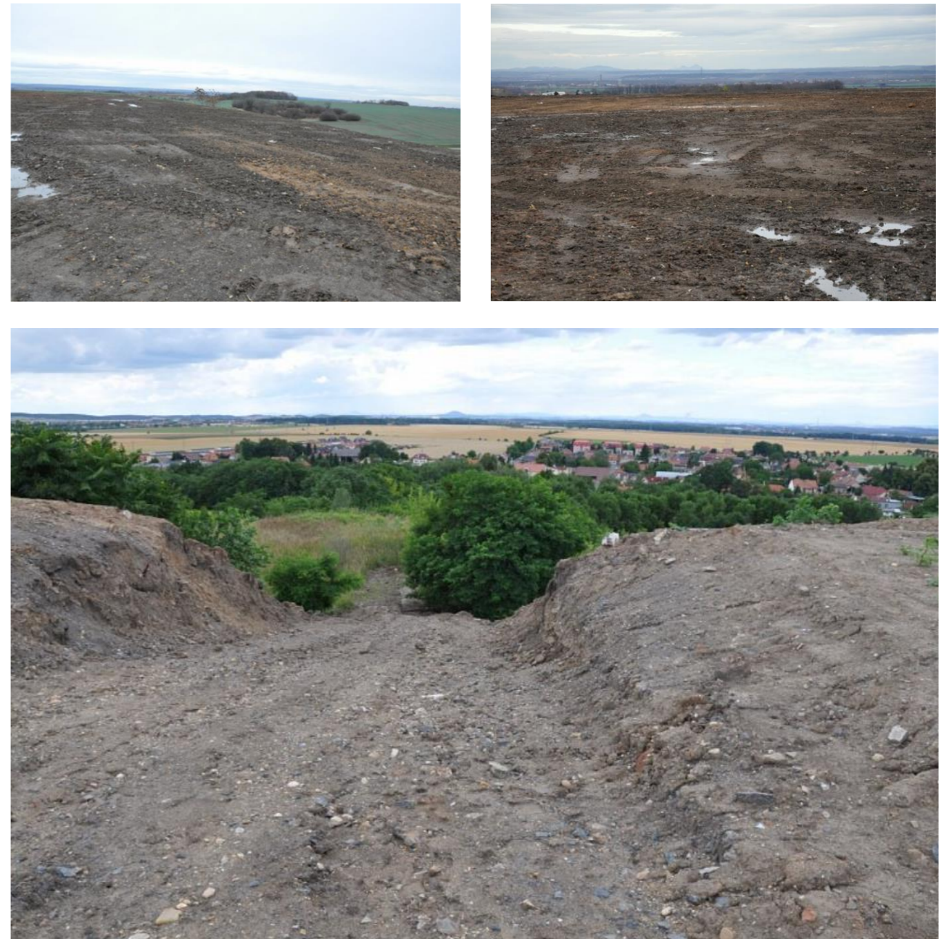
Obr.č.87, 88, 89: Koruna skládky po návodu ornice (zdroj: https://www.velen.cz )
