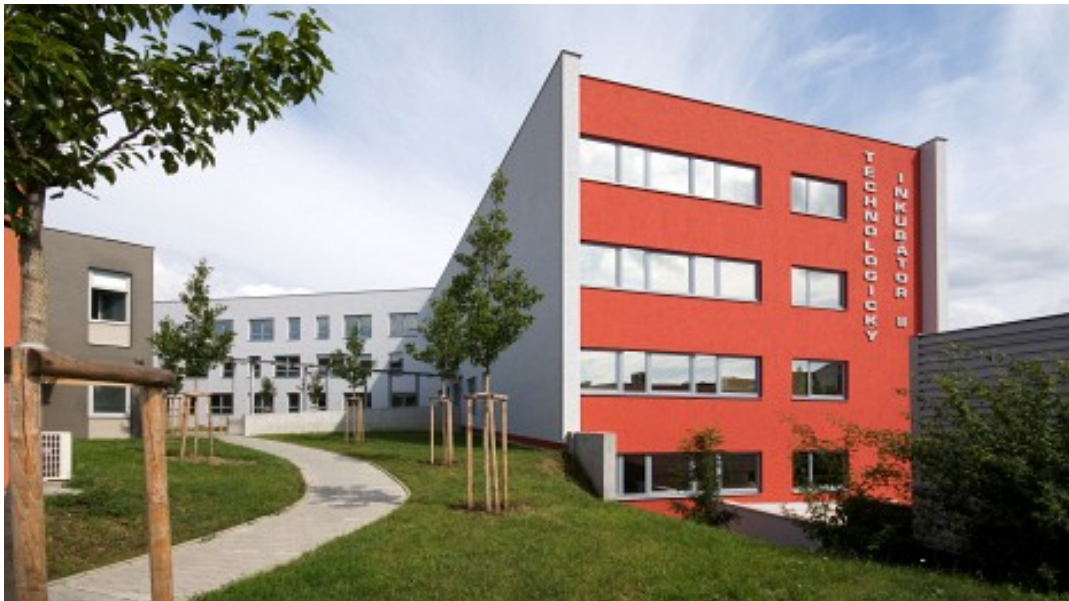
Obr. 7. Nová budova JIC (Zdroj: google.com)
