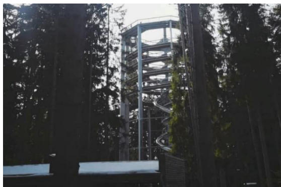
Obrázek 2 Stezka korunami stromů
