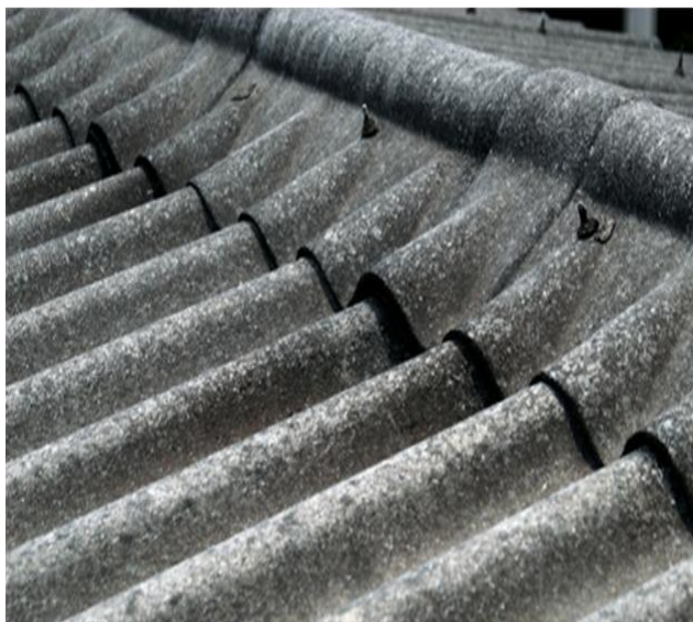
Obrázek 5 – Eternitová střešní krytina
