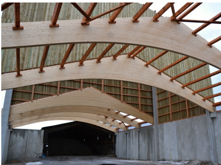
Obrázek 10.2 Plnostěnný střešní vazník [20]
