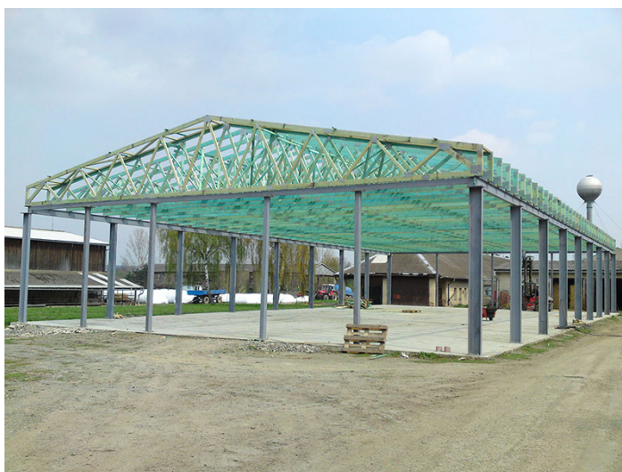
Obrázek 10.1 Příhradový dřevěný vazník [19]
