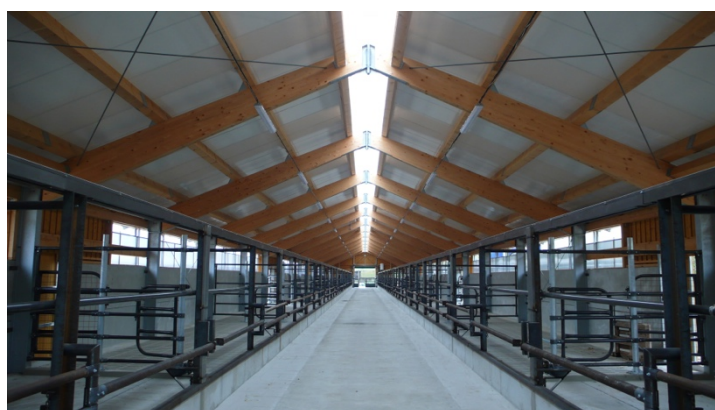
Obrázek 10.4 Zastřešení stáje plnostěnným vazníkem [22]
