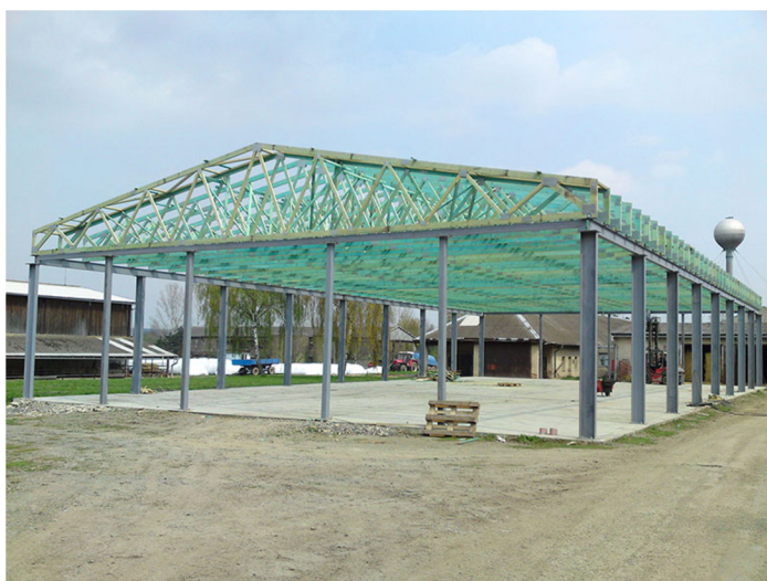
Obrázek 10.1 Příhradový dřevěný vazník [19]
