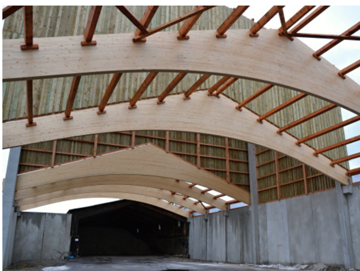
Obrázek 10.2 Plnostěnný střešní vazník [20]
