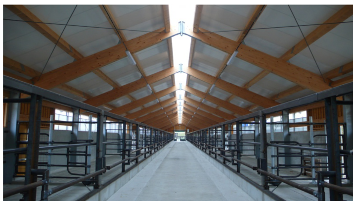
Obrázek 10.4 Zastřešení stáje plnostěnným vazníkem [22]
