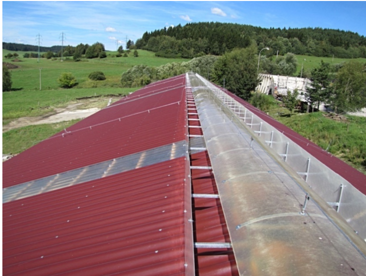
Obrázek 4.7 Větrací hřebenová štěrbina [4]
