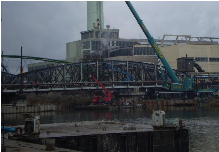
Obr. 1- Rekonstrukce železničního mostu Kolín
