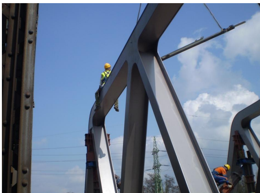
Obr. 13 - Práce na bočnici konstrukce mostu
