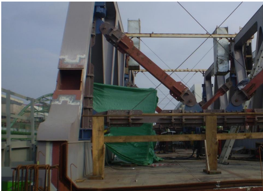
Obr. 22 - Krytá konstrukce pro svářeče
