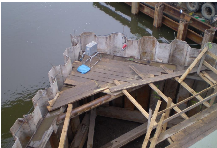
Obr. 5 - Vhodný rozvod elektrického proudu
