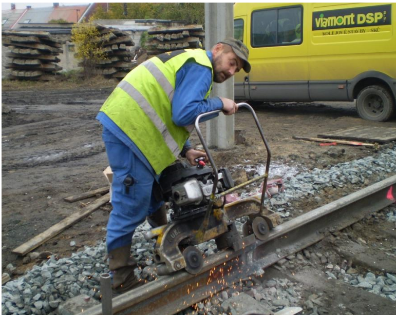
Obr. 8 - Broušení sváru na koleji
