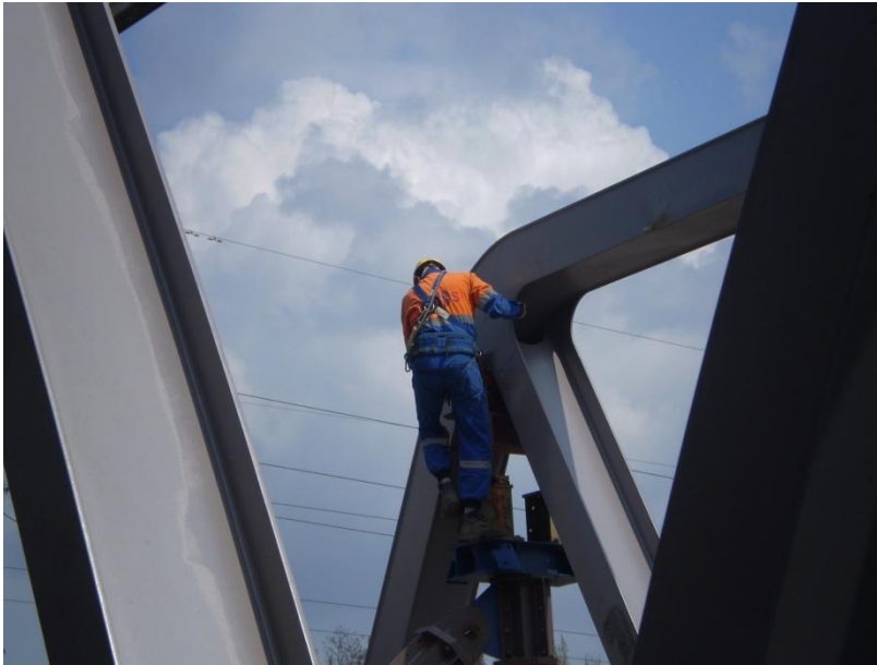
Obr. - 14 Vstup na bočnici konstrukce mostu
