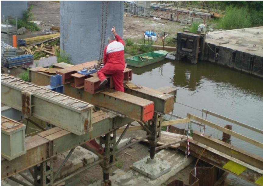
Obr. 9 - Vázání materiálu
