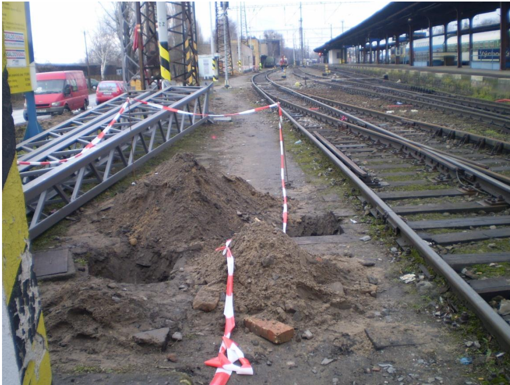
Obr. 33 - Nezabezpečený výkop 1
