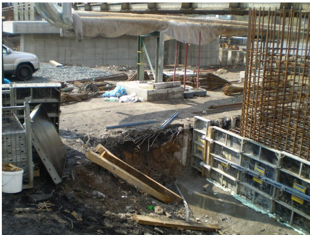
Obr. 35 - Nezabezpečený výkop 3
