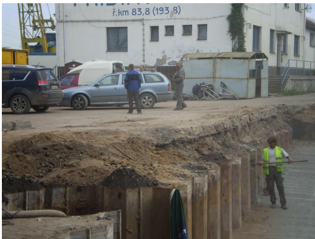
Obr. 36 - Nezabezpečený výkop 4
