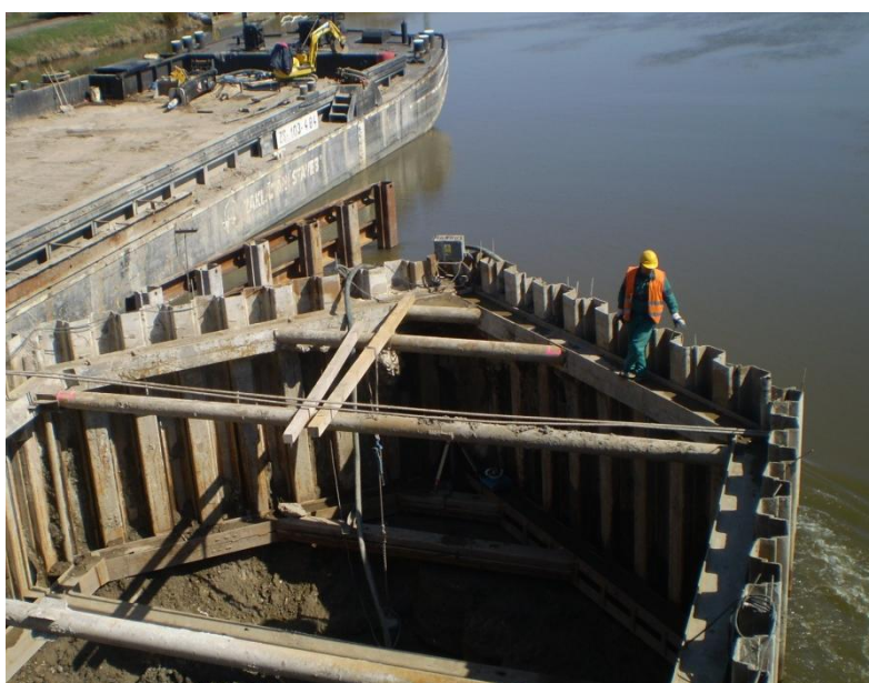
Obr. 10 - Práce na základech pilíře
