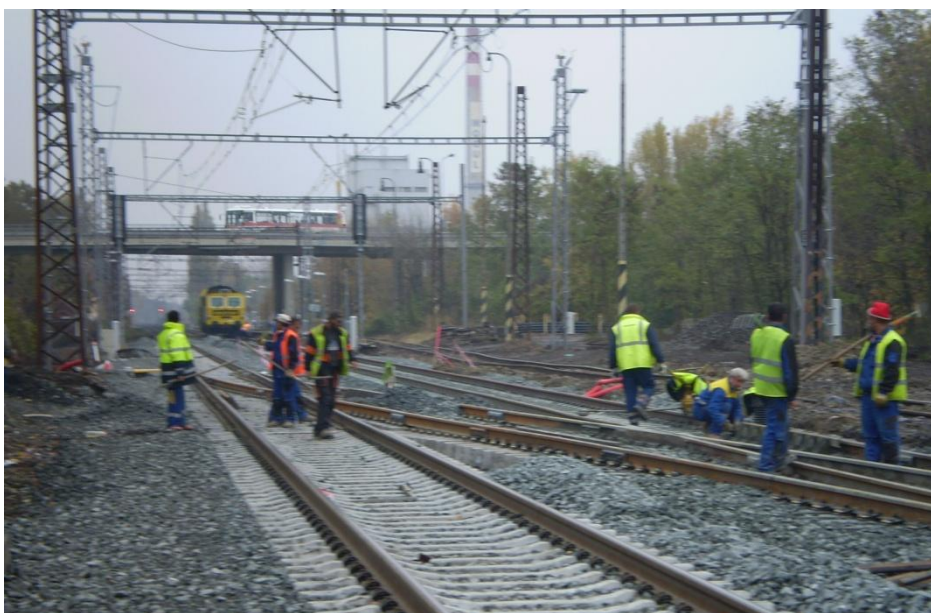
Obr. 3 - Práce na kolejišti
