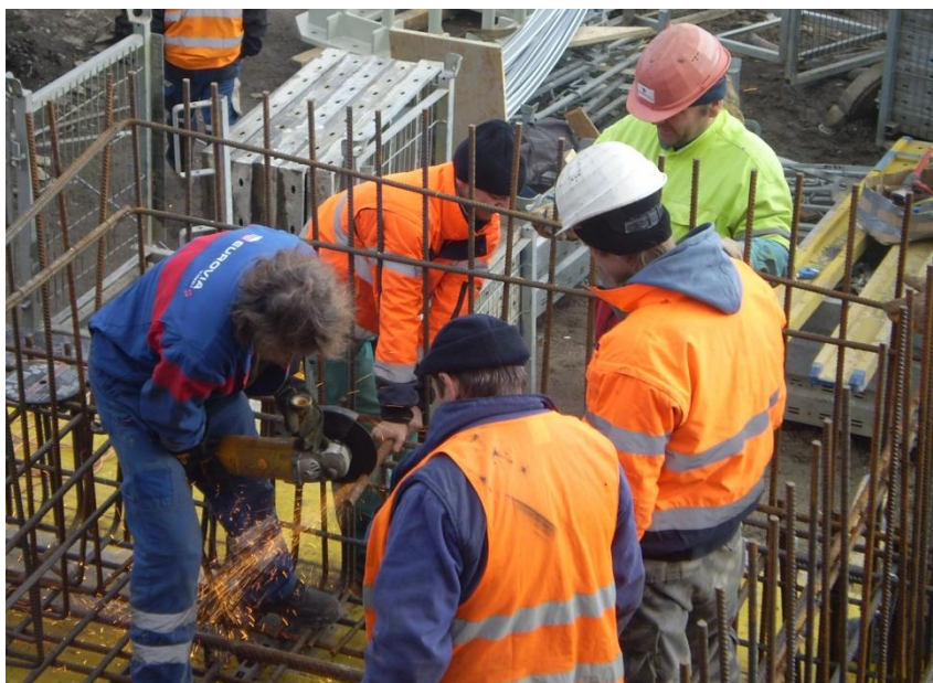
Obr. 7 - Rozbrušování ocelových prutů 1
