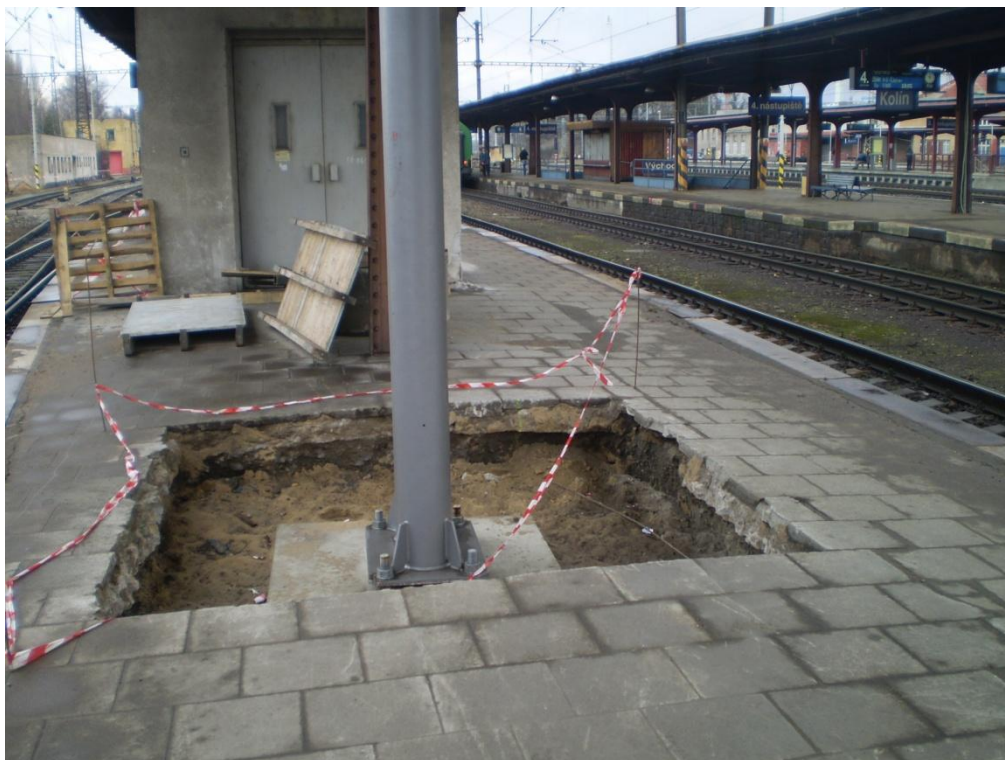
Obr. 34 - Nezabezpečený výkop 2
