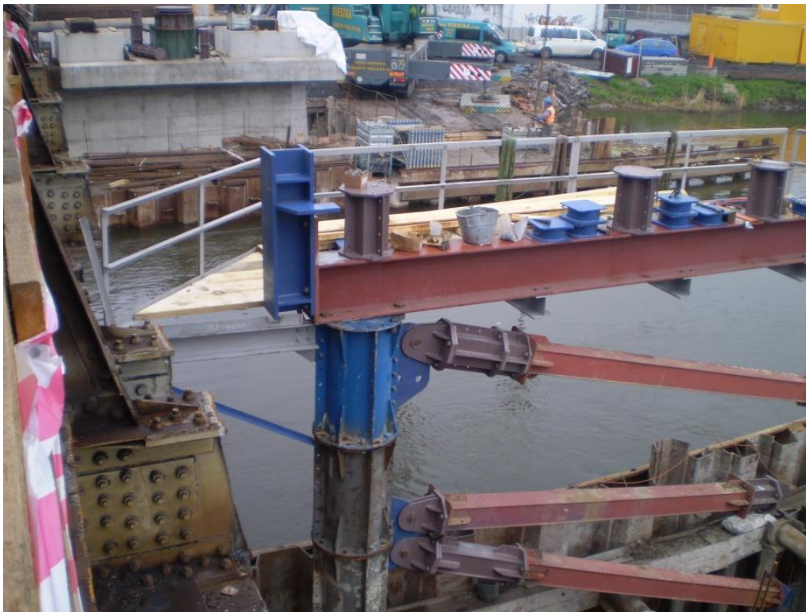
Obr. 12 -Vstup na lávku
