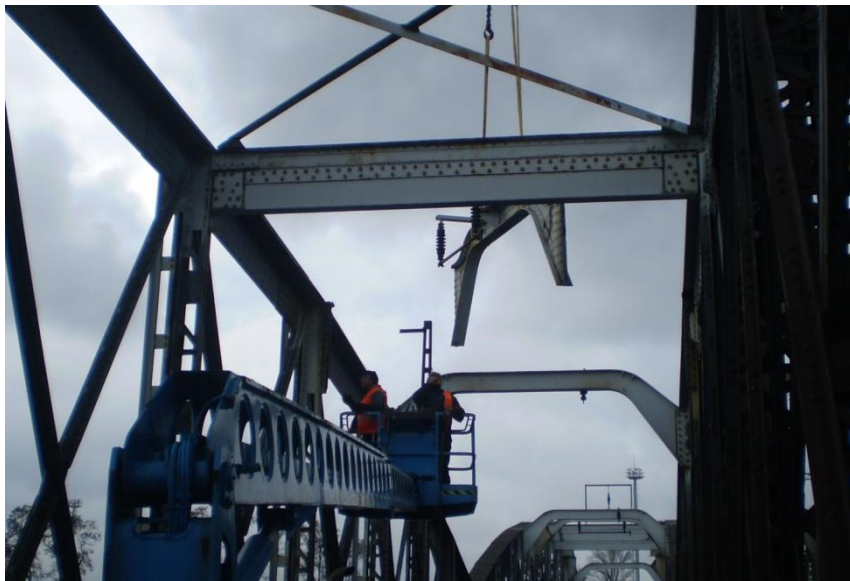
Obr. 6 - Přemísťování materiálu jeřábem
