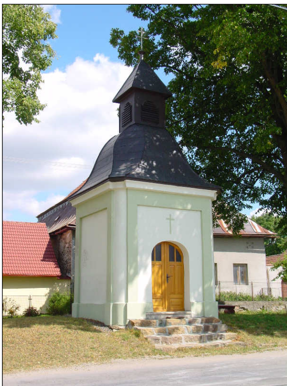
Kněževes – kaple - číslo rejstříku ÚSKP 18016/7-4132
