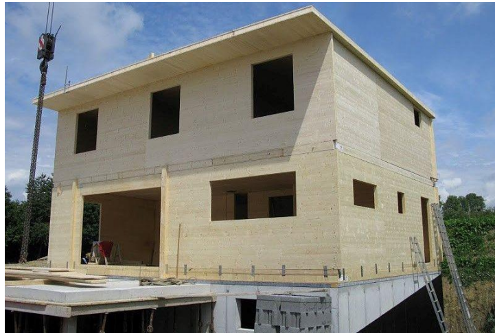
Obrázek 6: Ukázka panelové dřevostavby (Novatop)
