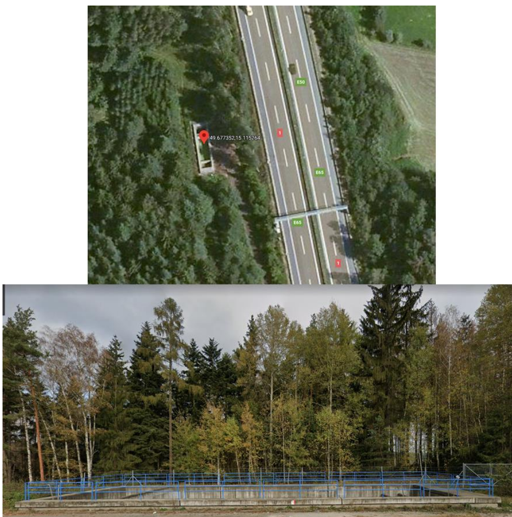
Obr. 43: Usazovací nádrže v blízkosti dálnice D1 („lapoly“)
