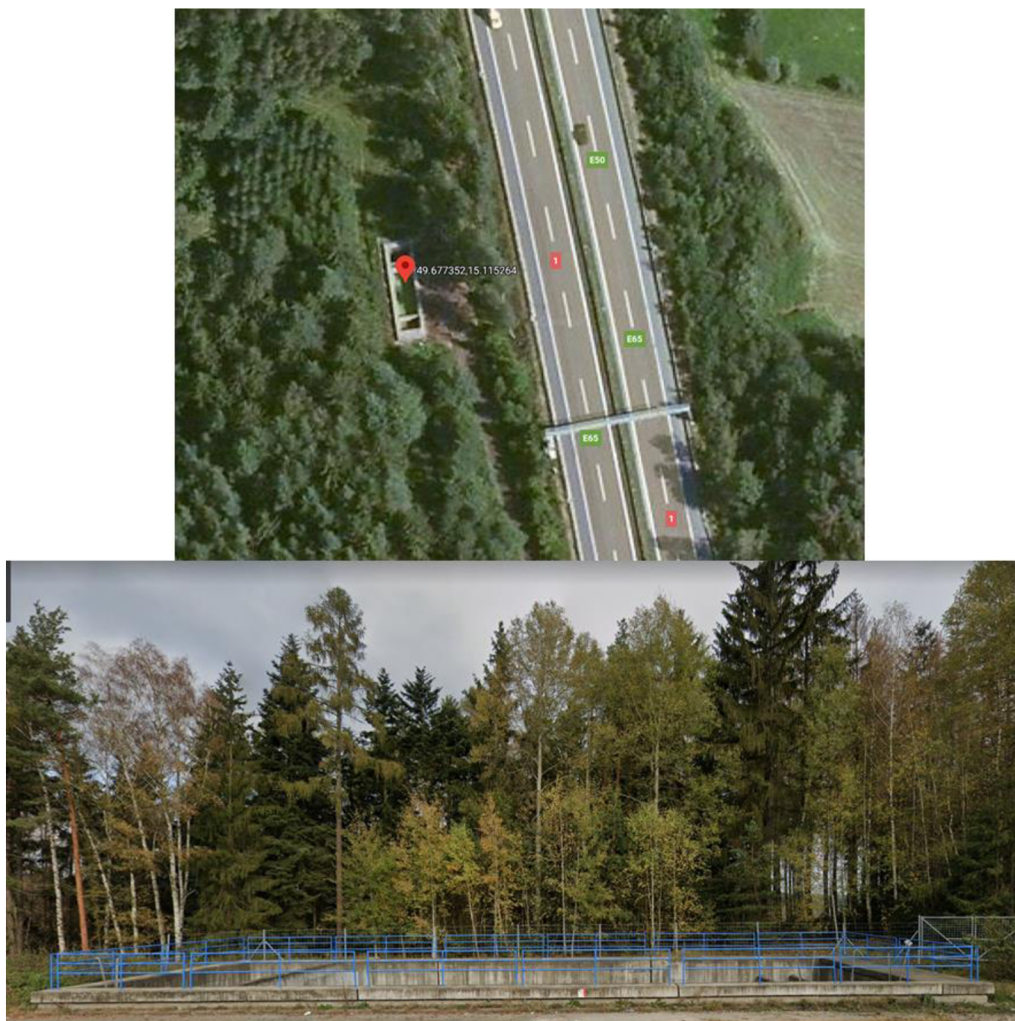
Obr. 43: Usazovací nádrže v blízkosti dálnice D1 („lapoly“)
