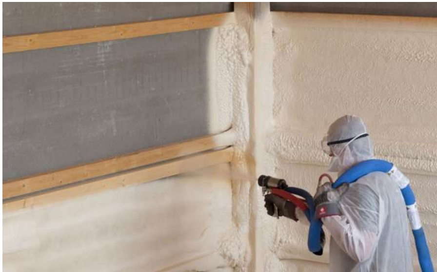
Obrázek 17: Aplikace PUR izolace
