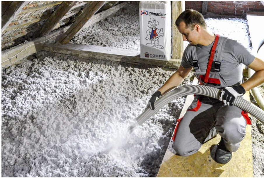
Obrázek 14: Aplikace celulózové izolace
