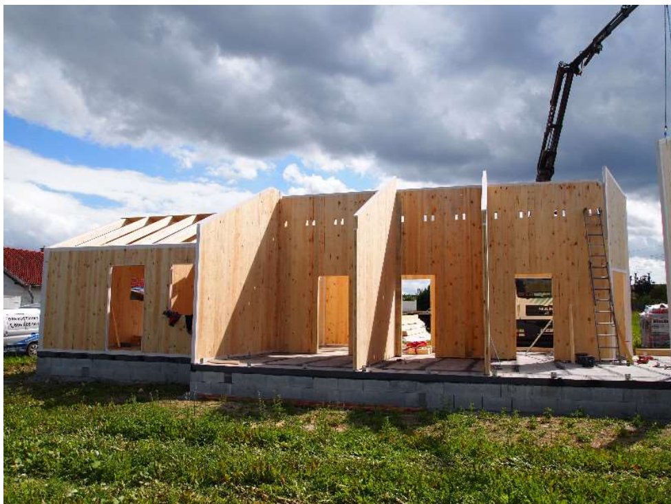
Obrázek 5: Konstrukce z CLT panelů
