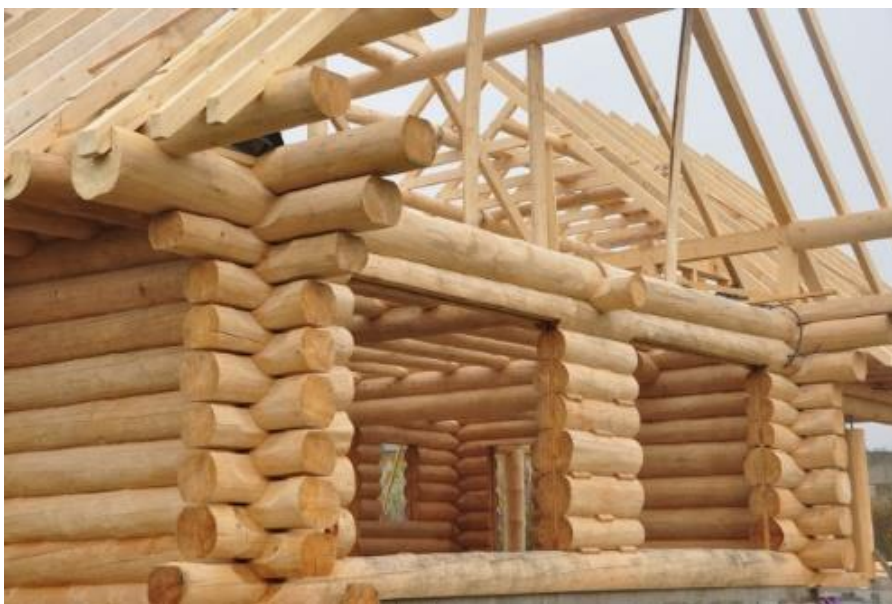
Obrázek 6 Dřevěná konstrukce-srub (přírodní domy, 10.4.2018)
