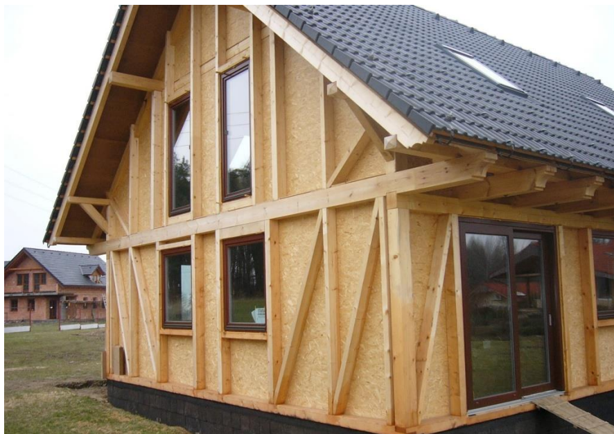
Obrázek 7 Dřevěná konstrukce č.2 (Alpmont, 17.4.2018)
