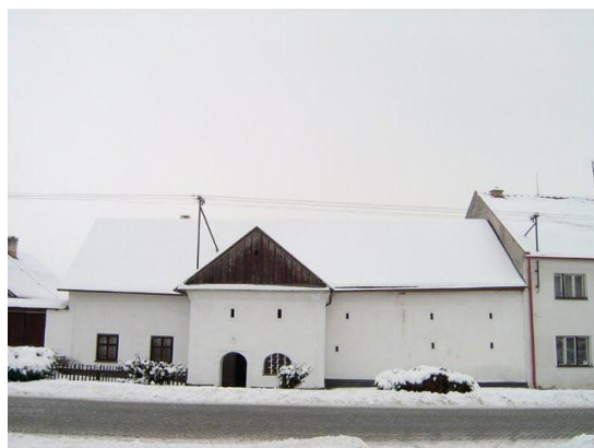
Stavení v obci s původním žudrem
