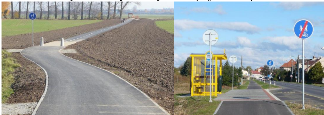
Obrázek č. 3: Nově vybudované cyklostezky v rámci projektu “Bezpečná Litovel”
