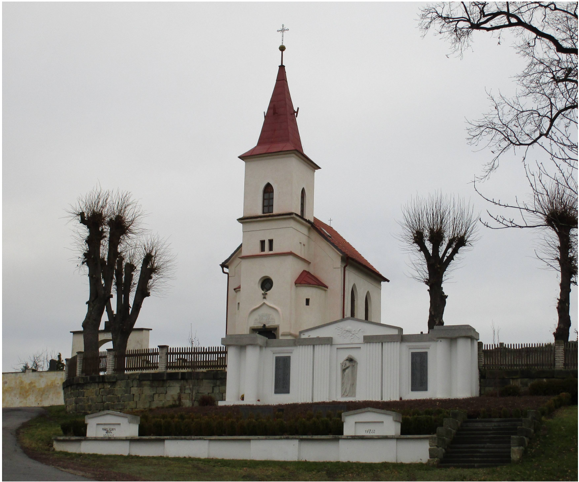
Příloha č. 14: Hřbitovní kaple Nanebevzetí Panny Marie
