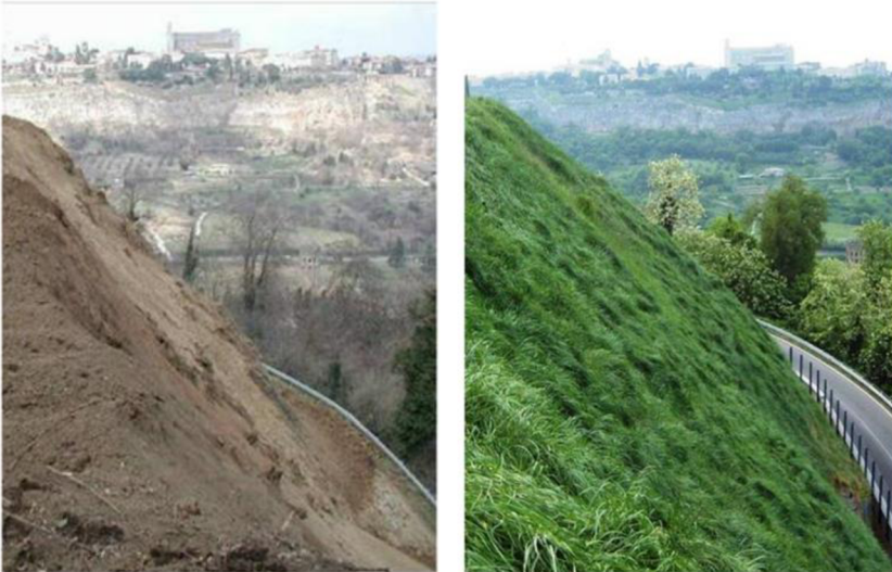
Obr. 4 Příklad protierozního využití kořenů travních porostů v praxi – svah před a 18 měsíců po zatravnění ve střední Itálii (Cecconi et al. 2013).
