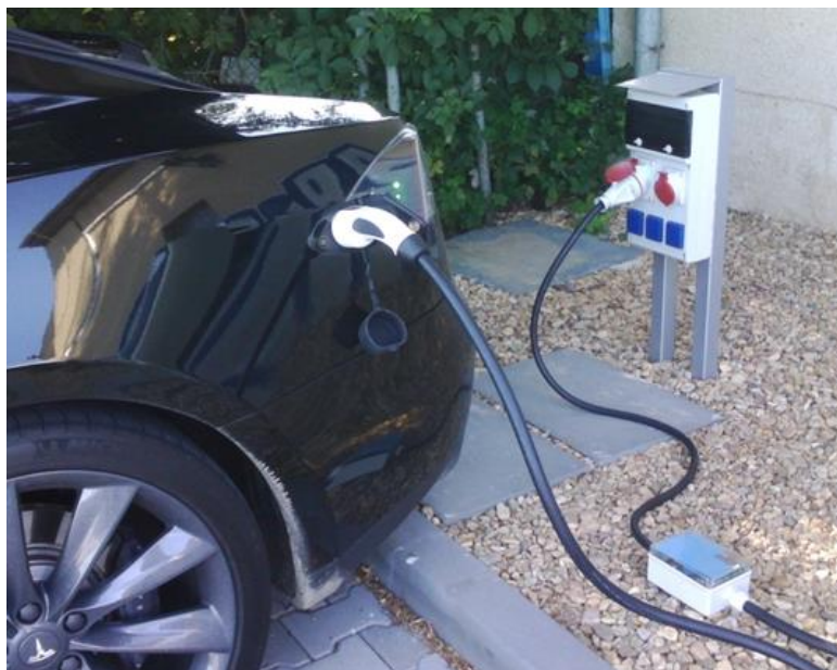
Obrázek 3-3 Středně rychlá dobíjecí stanice pomocí rozvaděče [5]
