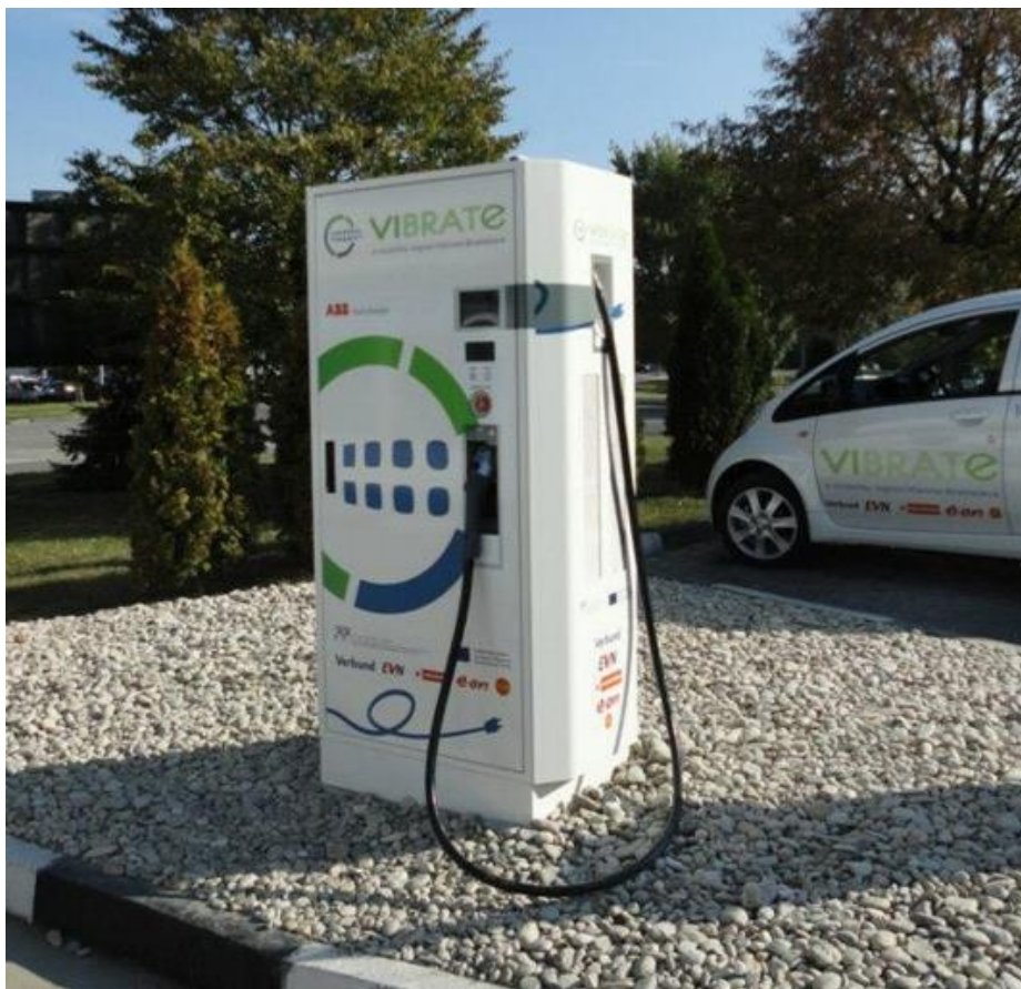
Obrázek 3-5 DC rapid charger CHAdEMO [5]
