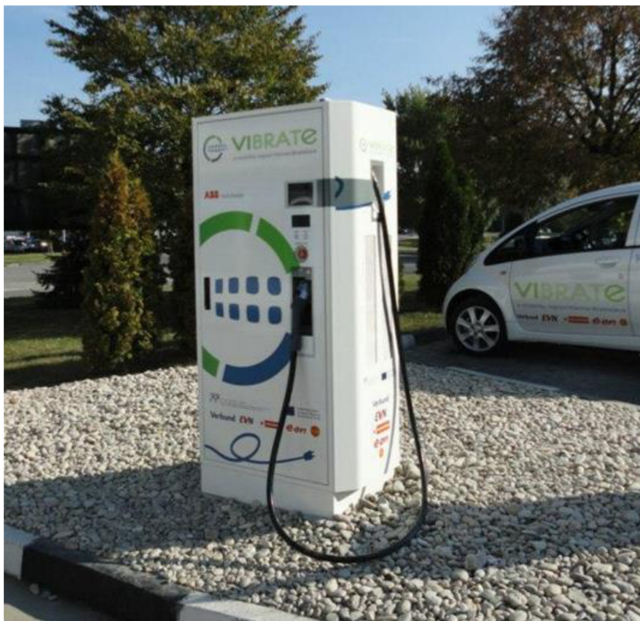
Obrázek 3-5 DC rapid charger CHAdeMO [5]
