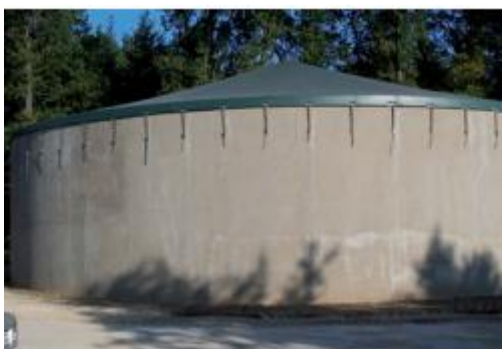
Obrázek č. 15: Krytá skladovací nádrž fermentačního zbytku (Lukehurst et al. 2014)
