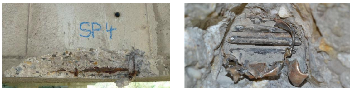
Obr. 7-1: Fotodokumentace zkoumání konstrukce na případnou korozi výztuže betonářské (vlevo) a výztuže předpínací (vpravo)
