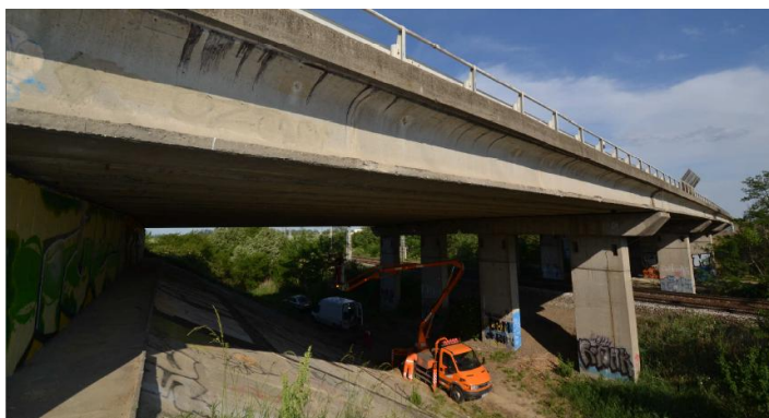
Obr. 8-1: Dálniční most ev. č. D2-046..2
