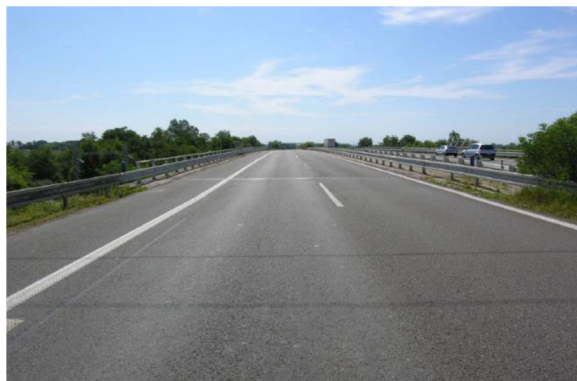
Obr. 8-2: Pohled na levý most ve směru staničení, tj. od Brna směrem k Bratislavě
