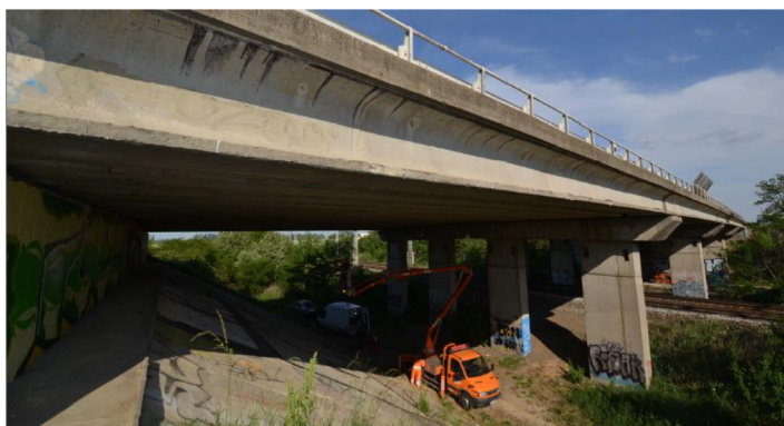
Obr. 8-1: Dálniční most ev. č. D2-046..2
