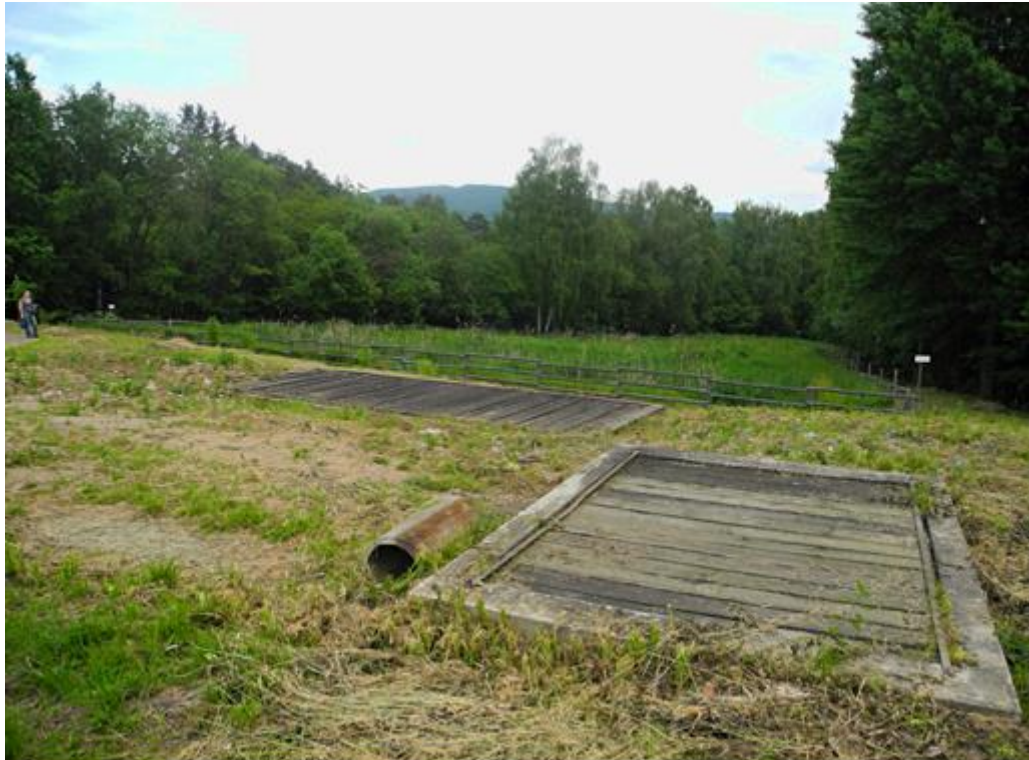
Obr. 15 Celkový pohled na umělý mokřad
