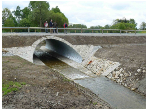
Obr. 4.2: Most v k. ú. Staré Město pod Landštejnem [11]
