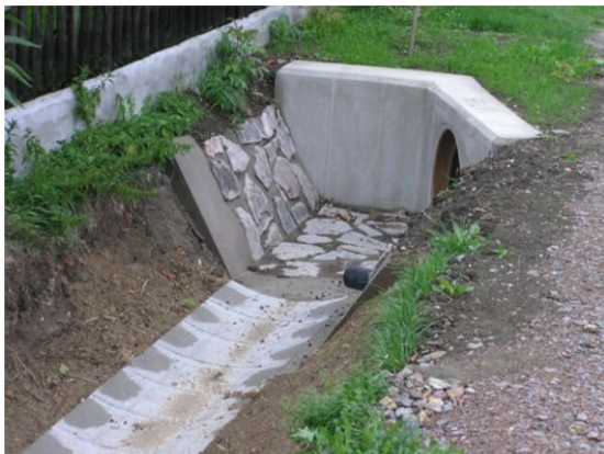
Obr. 4.1: Trubní propustek v k. ú. Bořice u Hrochova Týnce [10]
