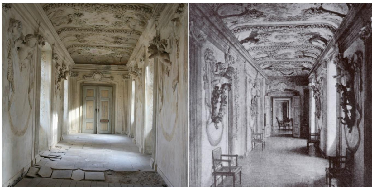
obr. 34 tzv. Andělská chodba zámku v Uherčicích dnešní stav v porovnání se stavem před poničením výzdob (kolem r. 1900). Baldassarre Fontana, štuková výzdoba interiérů zámku Uherčice, před 1696, štuk, zámek Uherčice.
