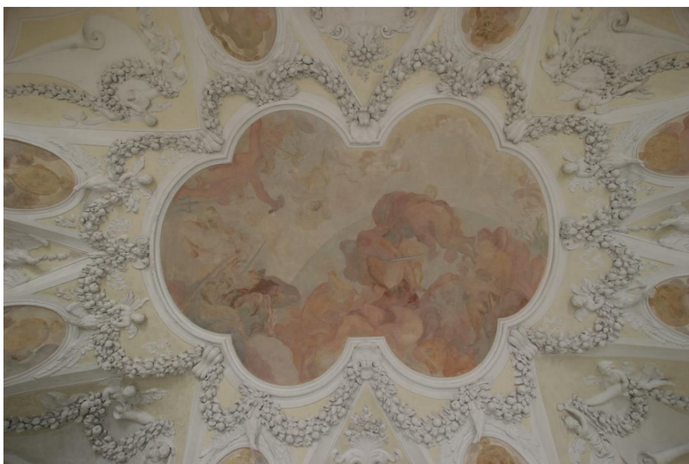
obr. 16 Detailní pohled na štukovou výzdobu klenby prostředního sálu. Baldassarre Fontana, štuková výzdoba prostředního sálu, 1693, štuk, sala terrena zámku v Kroměříži.
