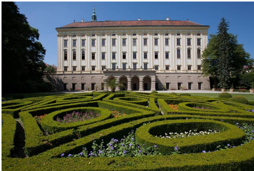
obr. 1 Pohled na severovýchodní křídlo kroměřížského zámku, v jehož přízemní části jsou situovány tři sály saly terreny a grotty. Giovanni Pietro Tencalla, severovýchodní křídlo rezidence, 1686–1698, zámek Kroměříž.
