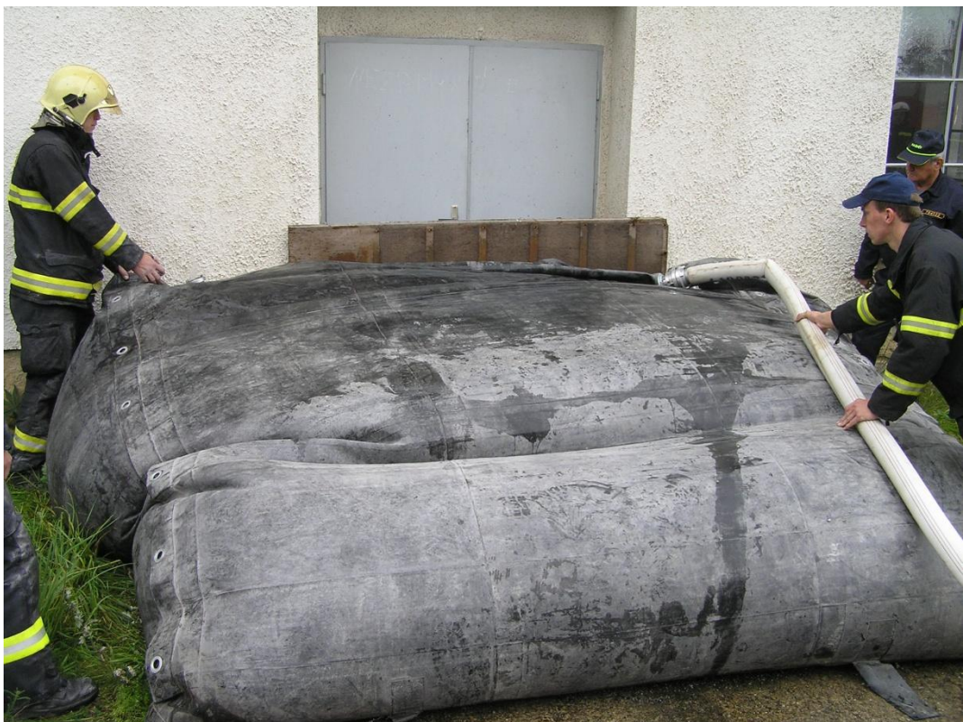
Obrázek č. 9 – zabezpečení objektu pomocí protipovodňové stěny
