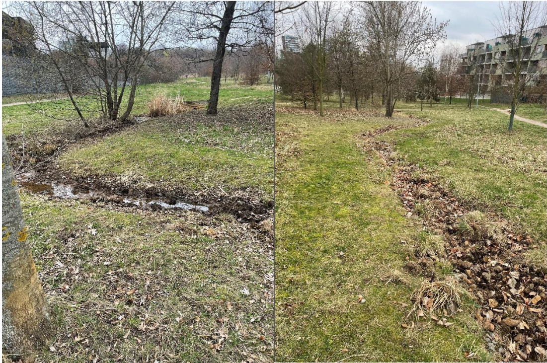
Obr. 39: Otevřené koryto Jinonického potoka
