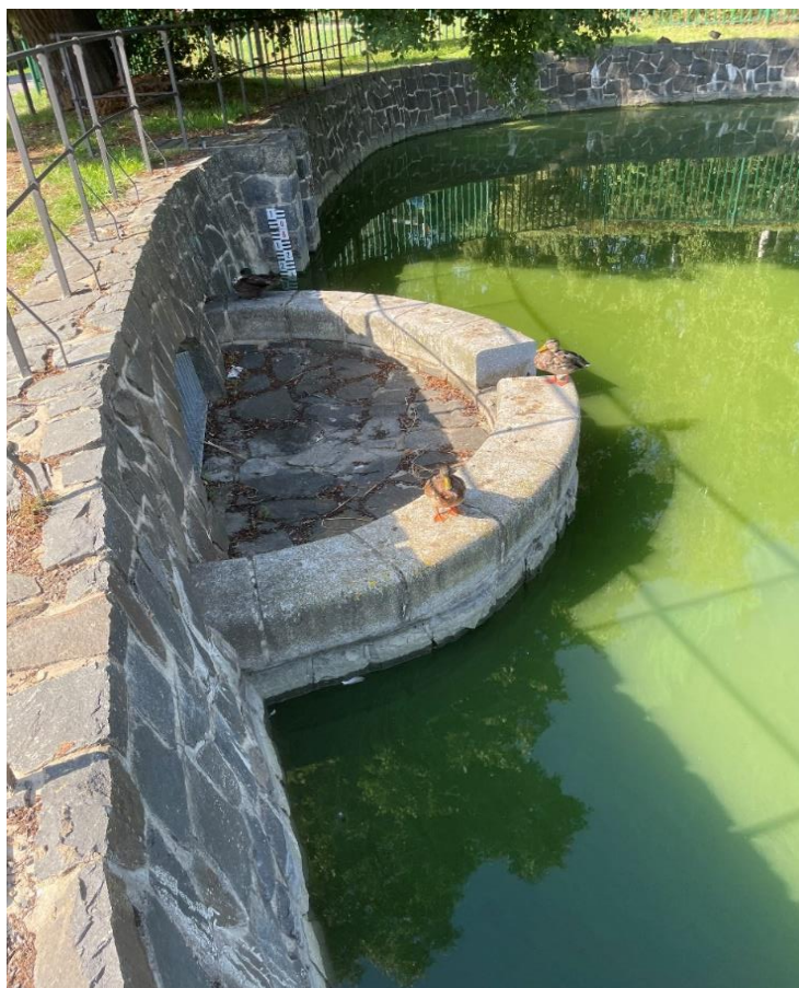
Obr. 28: Požerák, bezpečnostní přeliv a měřící zařízení
