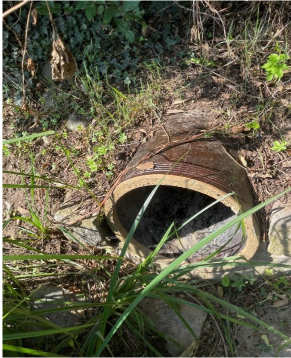
Obr. 30: Vyústění dešťové kanalizace DN400 ze sportovního areálu
