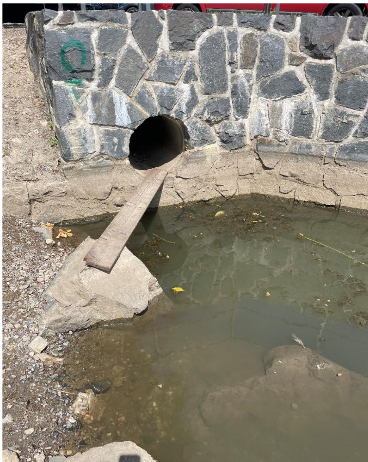
Obr. 29: Vyústění zatrubněného Jinonického potoka a dešťové kanalizace DN500
