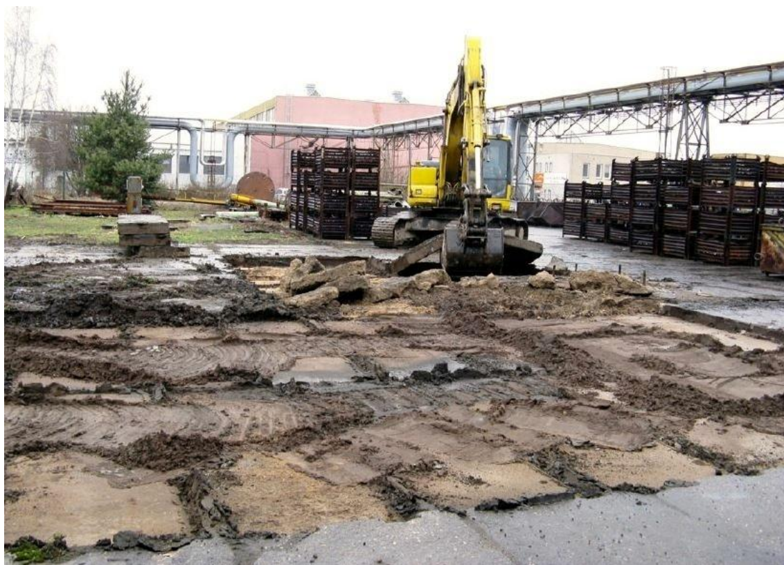
Fotografie č. 3: Oblast T1 „kalírna, kovárna“ – rozebírání zpevněné panelové plochy
