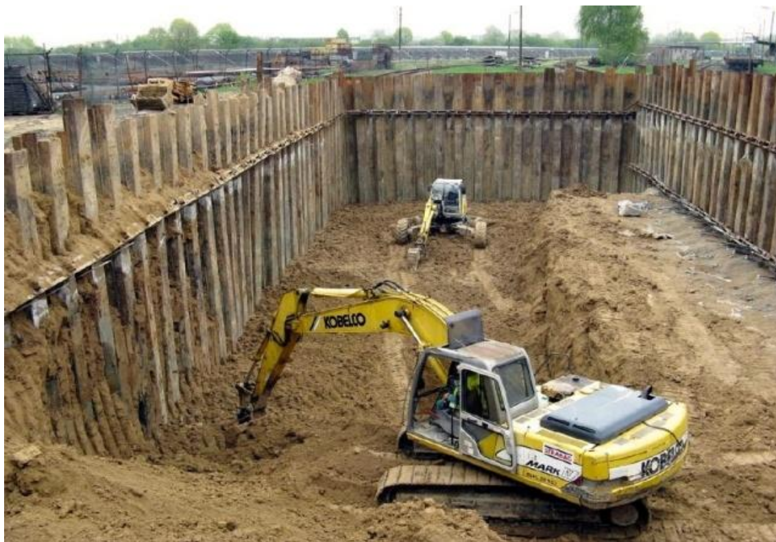
Fotografie č. 9: Oblast T2 „elektrodílny“ – sanační odtěžba
