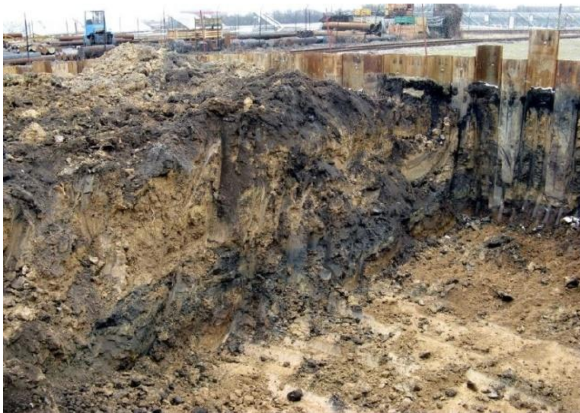
Fotografie č. 8: Oblast T2 „elektrodílny“ – odtěžba kontaminovaných zemin a materiálů
