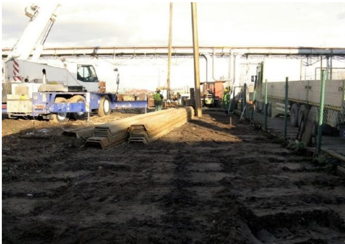
Fotografie č. 4: Oblast T1 „kalírna, kovárna“ – beranění (vibrování) štětových stěn
