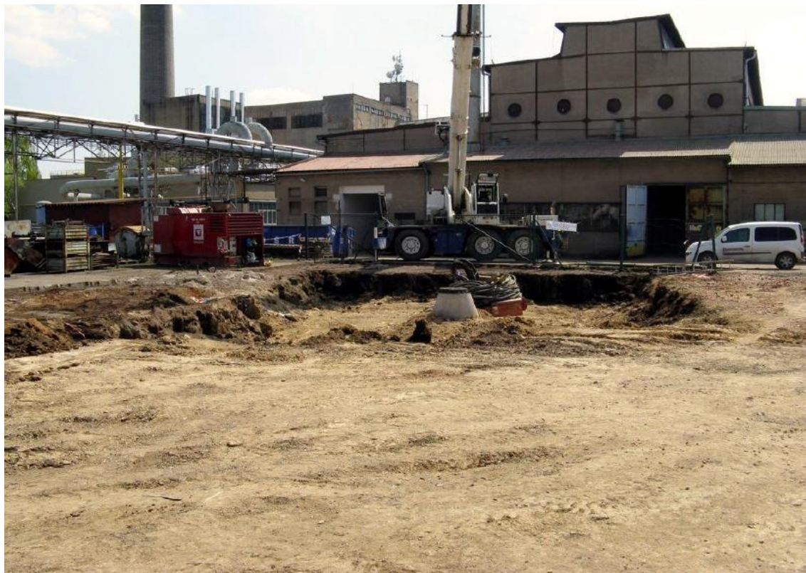
Fotografie č. 11: Oblast T1 „kalírna, kovárna“ – dokončování zásypu sanačního výkopu
