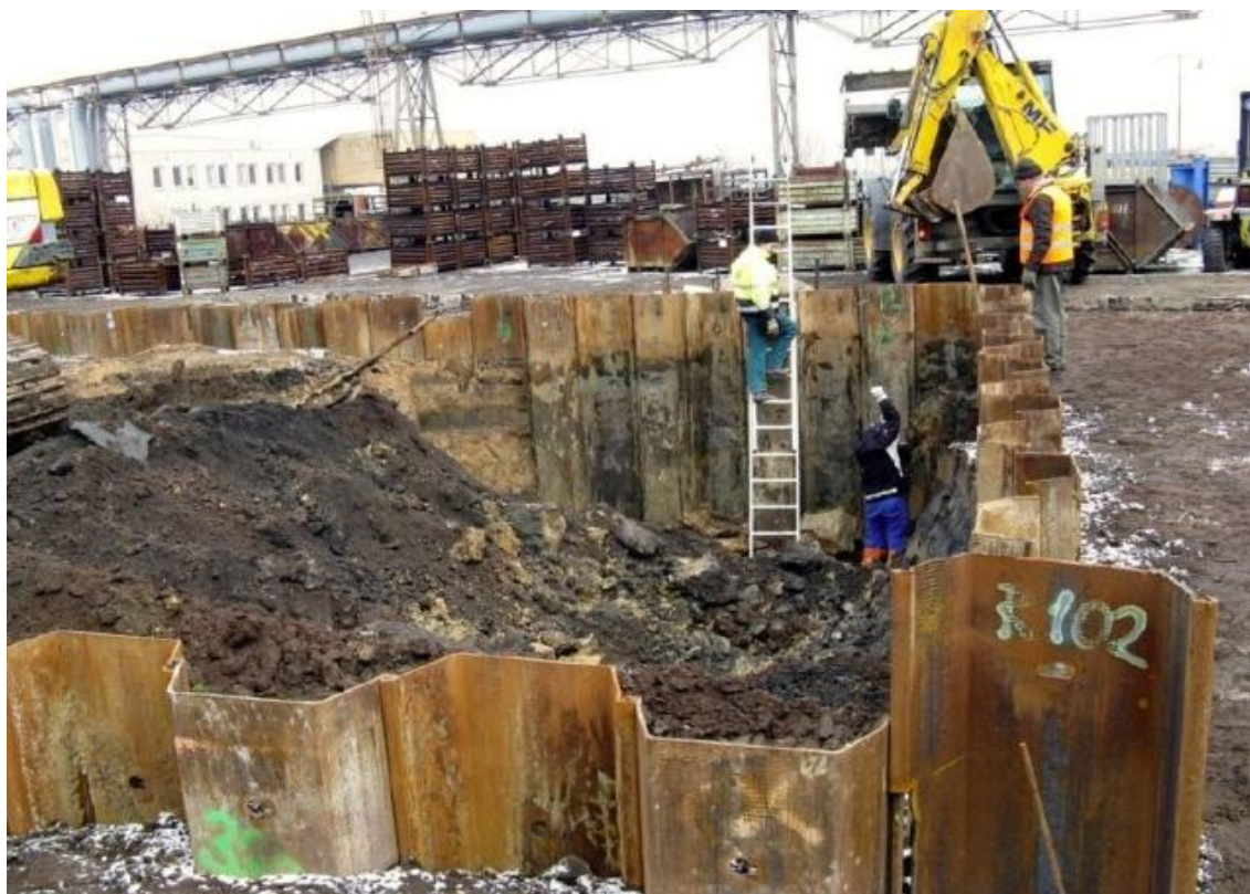
Fotografie č. 6: Oblast T1 „kalírna, kovárna“ – odtěžba kontaminovaných zemin a materiálů
