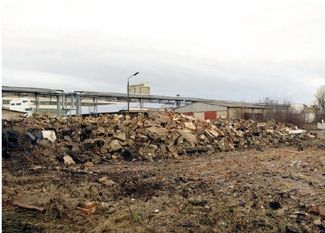
Fotografie č. 2: Oblast T3 „korea“ – demolice stavebních objektů
