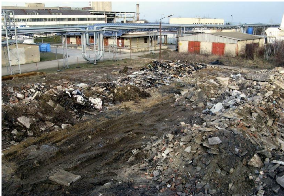
Fotografie č. 5: Oblast T3 „korea“ – třídění stavebních odpadů vzniklých při odstranění budov v rámci přípravy lokalit
