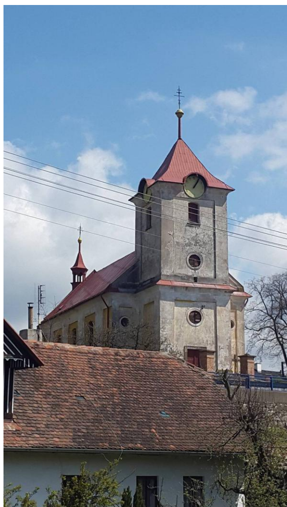
Obr. č. 79: Velká Jesenice- kostel
