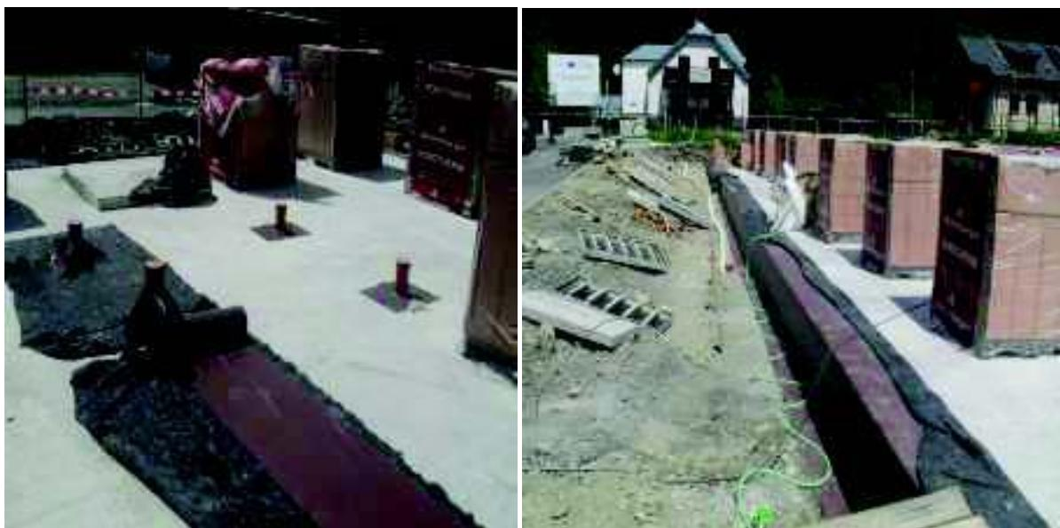
Pokud je v PD vodorovná izolace proti vlhkosti položí se pásy izolačního materiálu na zatvrdlou vyrovnávací maltu. Pásy musí být nejméně o 150 mm širší než bude tloušťka zdi.
