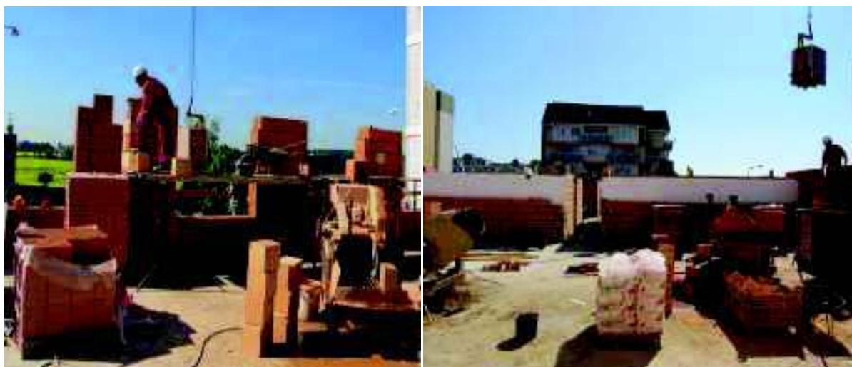
Malta ložné spáry se nanese na podklad ve stejné šířce jako je tloušťka zdi a v takové výšce, aby po osazení cihly byla dodržena předepsaná tloušťka spáry. Ložná spára musí být plně promaltována.
