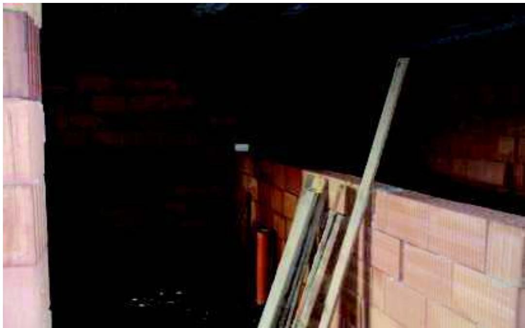
Při napojování příčky na nosnou zeď na tupo cihly se tato namaltuje z boku a namaltovanou stranou se přisadí a přimáčkne k nosné zdi. Při tomto zdění je nutné v každé druhé ložné spáře provést vyztužení v místě napojení plochou kotvou z nerez oceli, kterou ohnutou do pravého úhlu vodorovnou částí se zamáčkne do malty ložné
